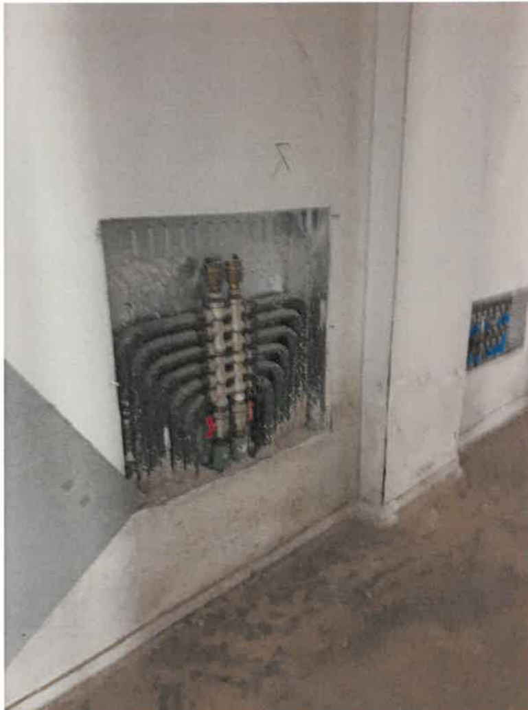
Particolare impianto riscaldamento (collettore)
