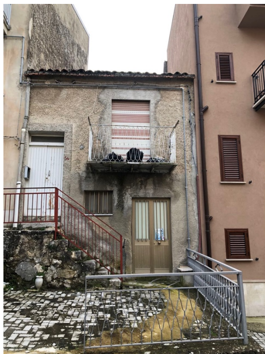
Foto esterna su via Valle n. 46 n. 48
