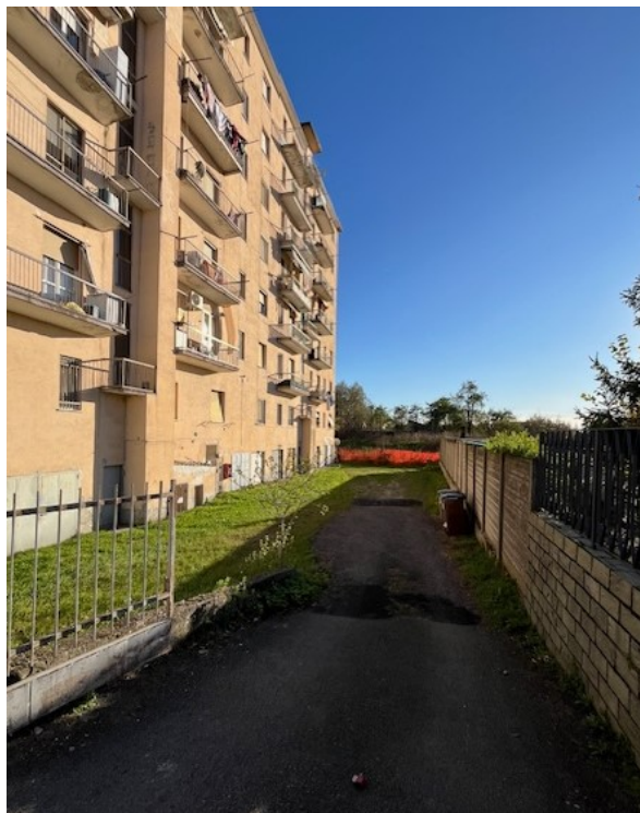
Vista del cortile interno su lato ovest del fabbricato
