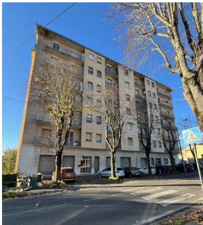
Vista del fabbricato dalla pubblica via Roma – lato est.
