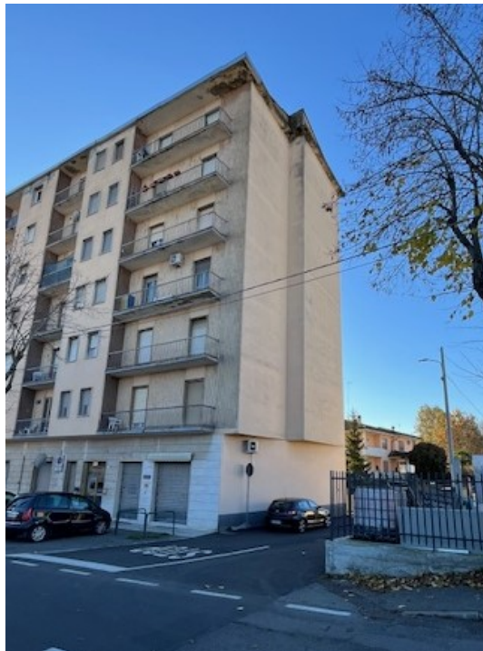
Vista del fabbricato dalla pubblica via Roma – lato nord
