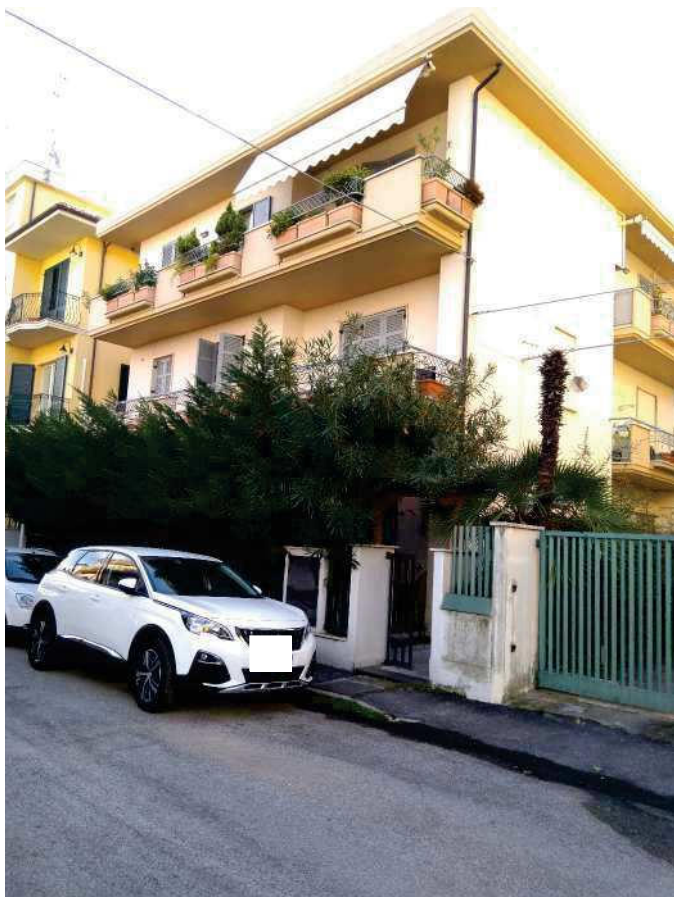
veduta generale del fabbricato
