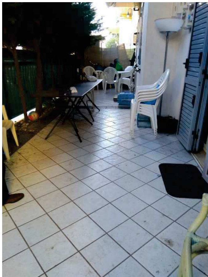
veduta della corte esterna pavimentata e dell'unità di pt adiacente
