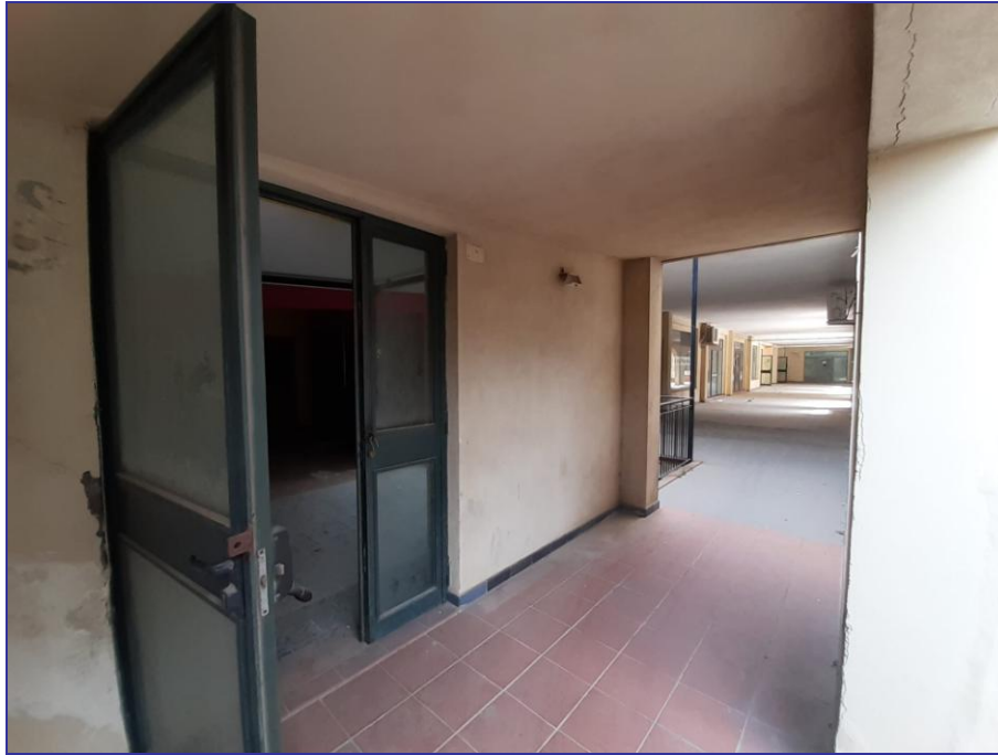
Foto 27 – Imm. 3 - Vista dell'ingresso con accesso alla parte destinata a magazzino.
