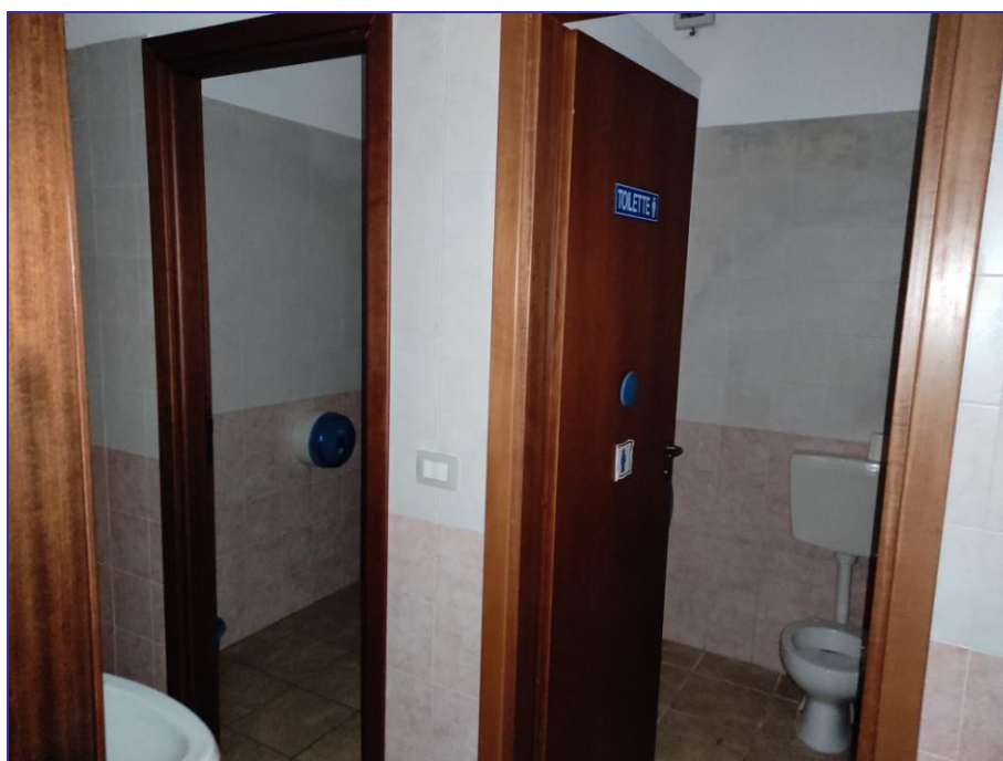
Foto 38 – Imm. 3 – Bagno uomini e donne.
