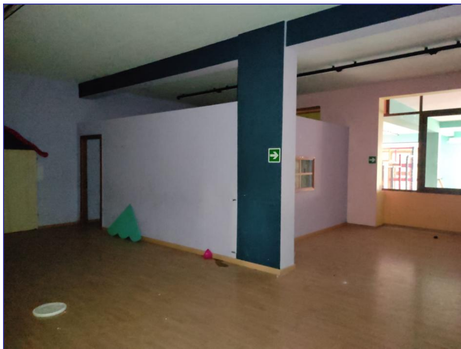
Foto 32 – Imm. 3 – Altra compartimentazione del locale con creazione di pareti divisorie basse all'interno del locale.
