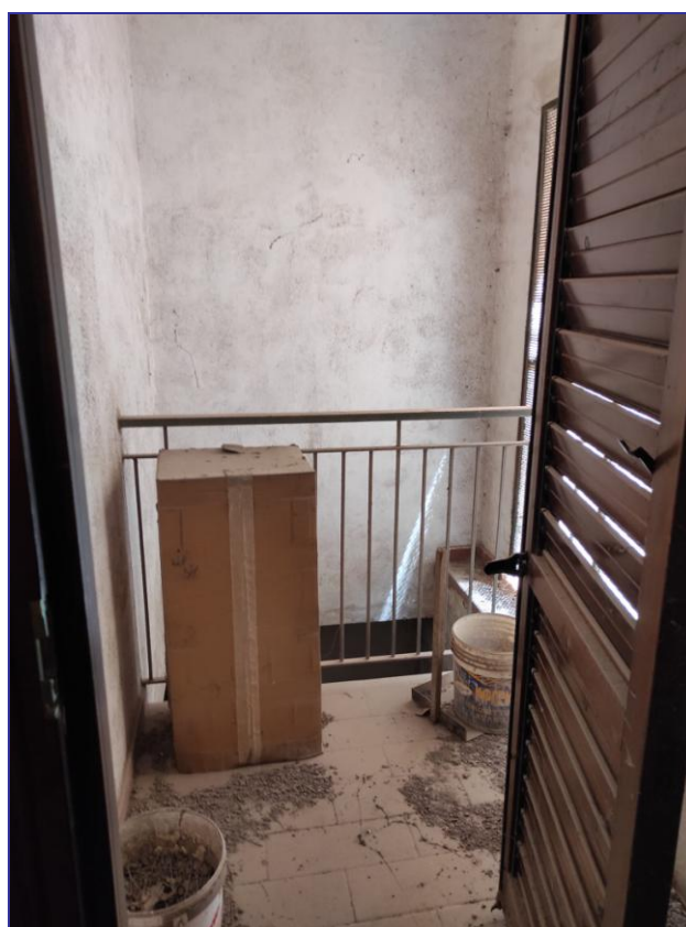
Foto 3 – Imm. 46 – Pozzo luce della parte condominiale con porzione di affaccio.
