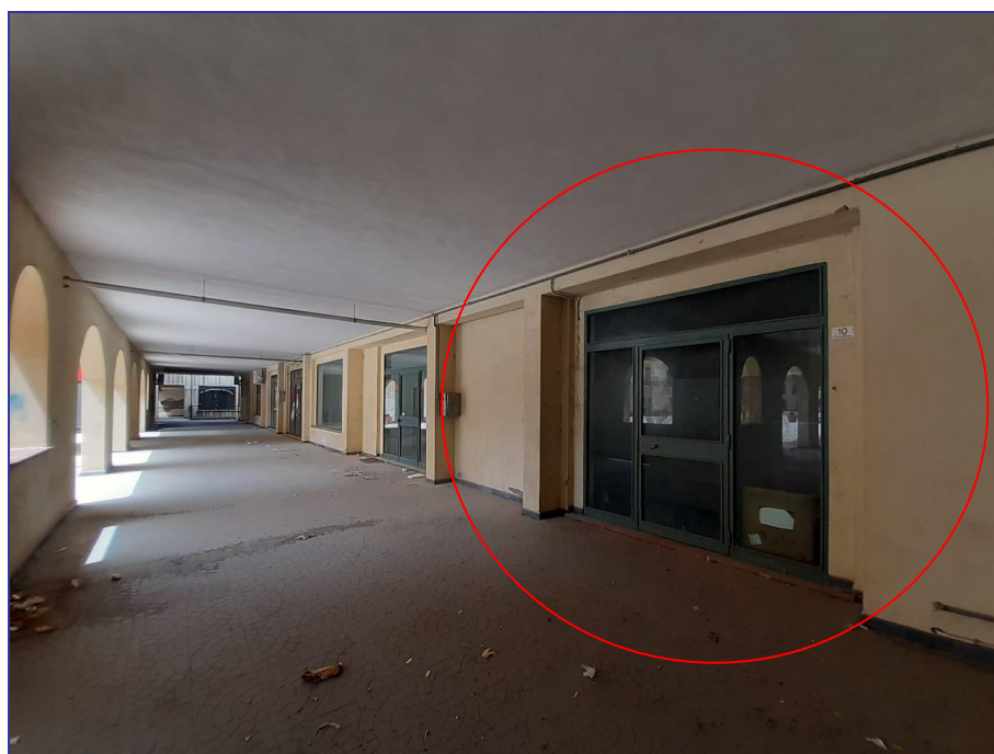
Foto 40 – Imm. 4 – Unico ingresso al locale commerciale individuato al numero Civico n. 10.
