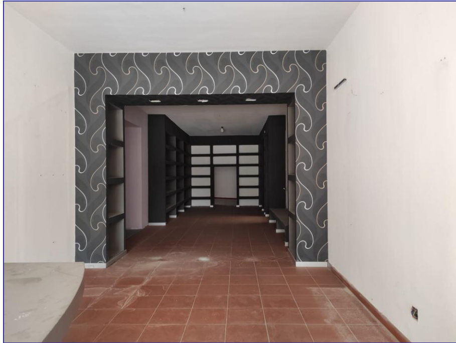
Foto 18 – Imm. 2 – Parte interna del locale commerciale con diverse divisioni interne realizzate mediante struttura e rifinitura in cartongesso.
