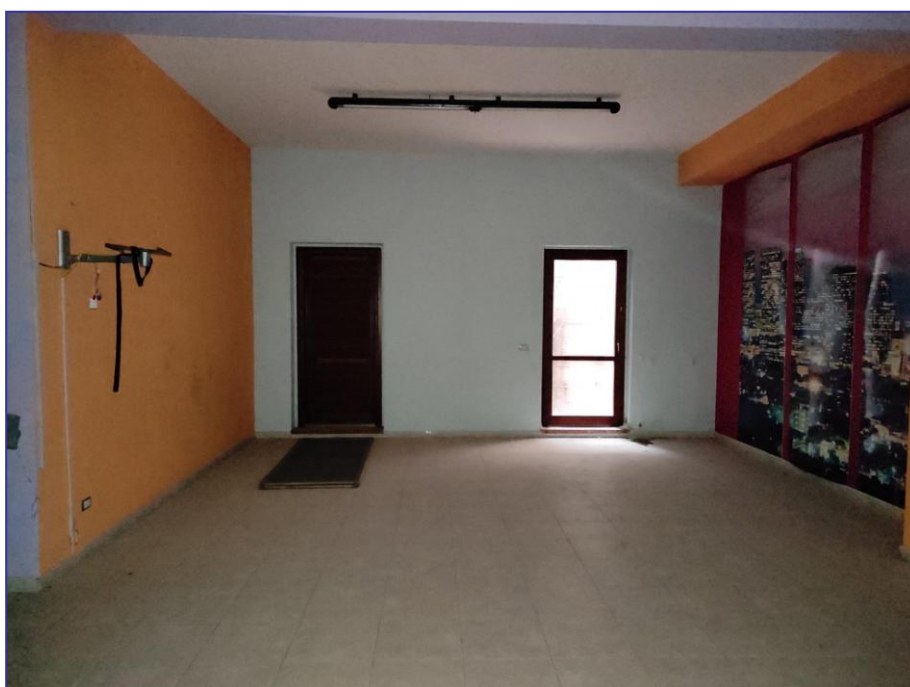
Foto 34 – Imm. 3 – Vista della parte retrostante con porte che immettono nell'intercapedine esistente.
