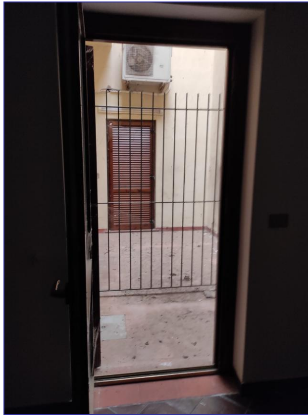
Foto 12 – Imm. 1 – Pozzo luce che permette illuminazione ed aerazione naturale alla parte retrostante.
