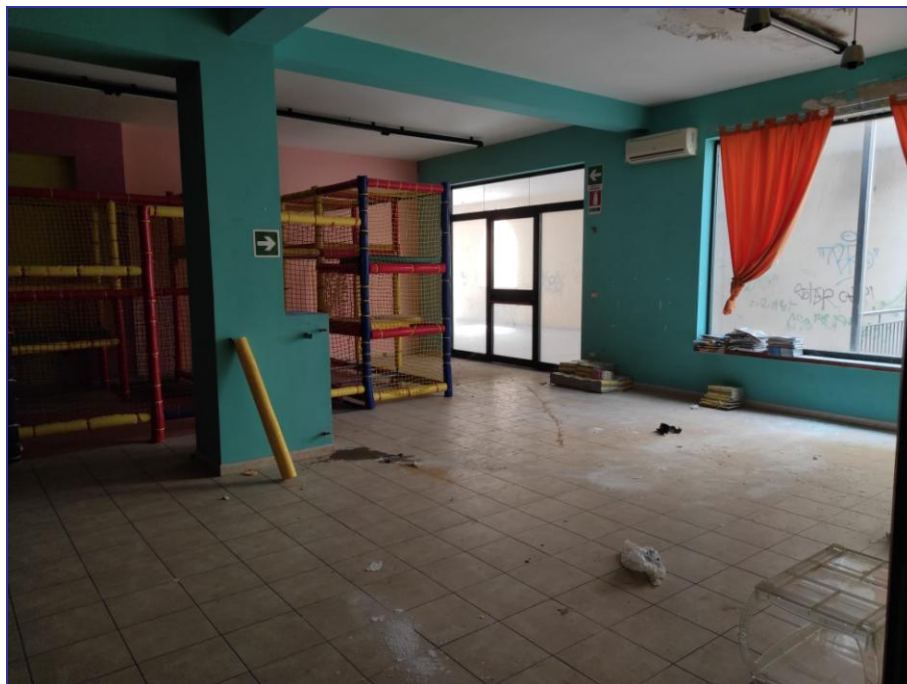
Foto 30 – Imm. 3 – Vista dall'interno dell'ingresso al locale commerciale con adiacente vetrina, accesso che avviene anche dalla Piazza Pier Santi Mattarella.
