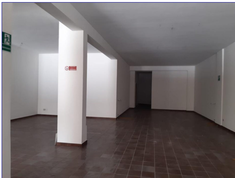
Foto 9 – Imm. 1 – Immagine della parte commerciale in prossimità dell'ingresso e con porta divisoria alla parte retrostante.
