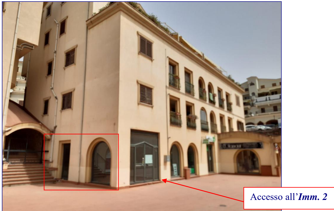
Foto 14 – Imm. 2 – Accesso all'immobile dalla Piazza Pier Santi Mattarella con vetrine espositivi laterali.
