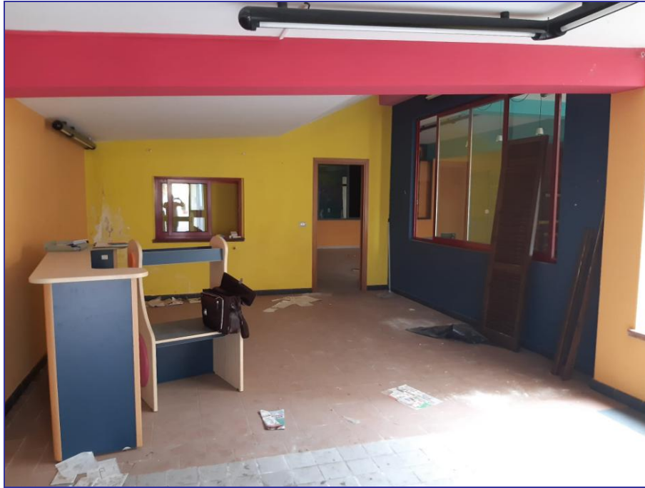
Foto 29 – Imm. 3 – Parte interna dell'ingresso del locale magazzino con porta che immette alla rimanente parte dello stesso.
