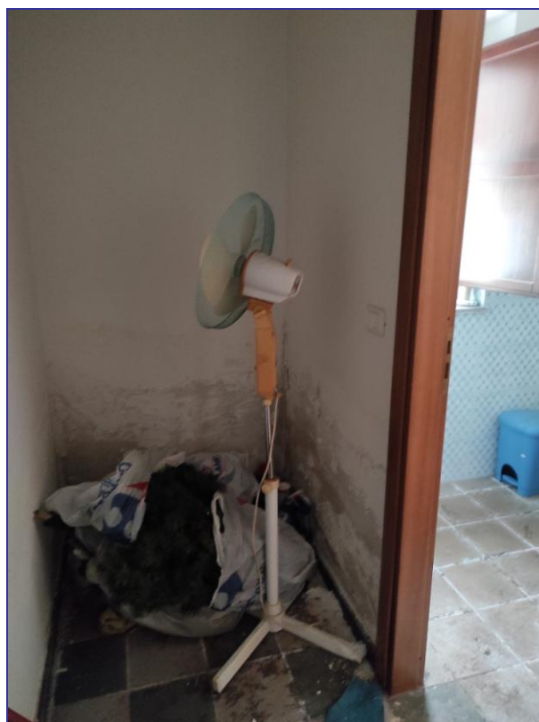
Foto 44 – Imm. 4 – Antibagno del locale.
