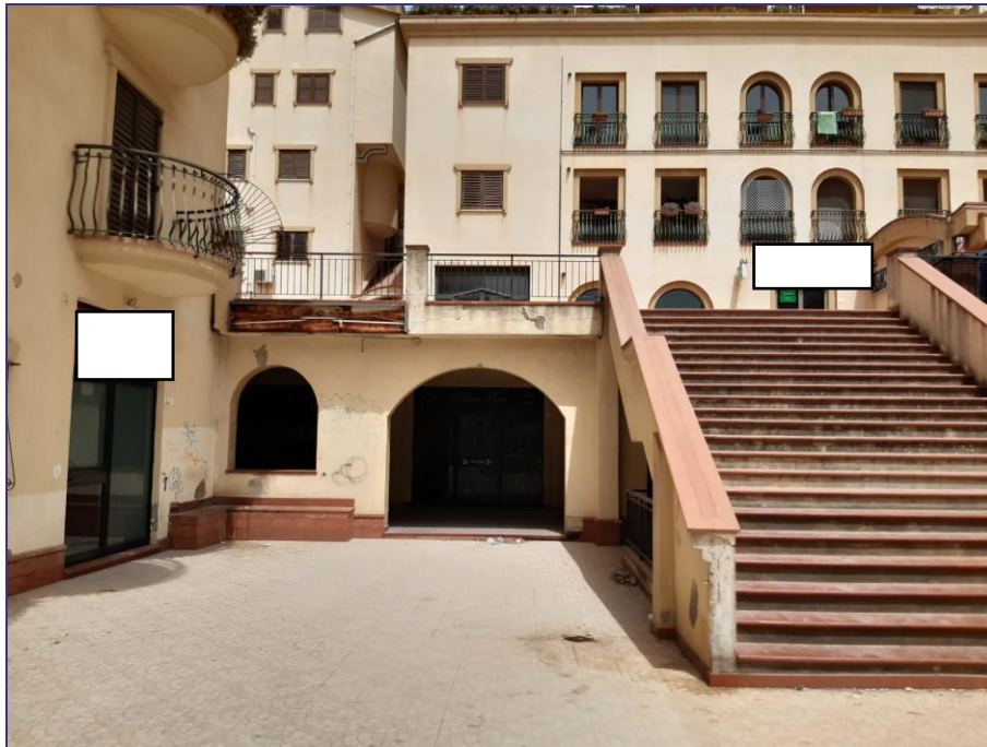
Foto 4 – Imm. 1 – Accesso sotto il portico da Piazza Pier Santi Mattarella in cui si ha l'ingresso dell'immobile.
