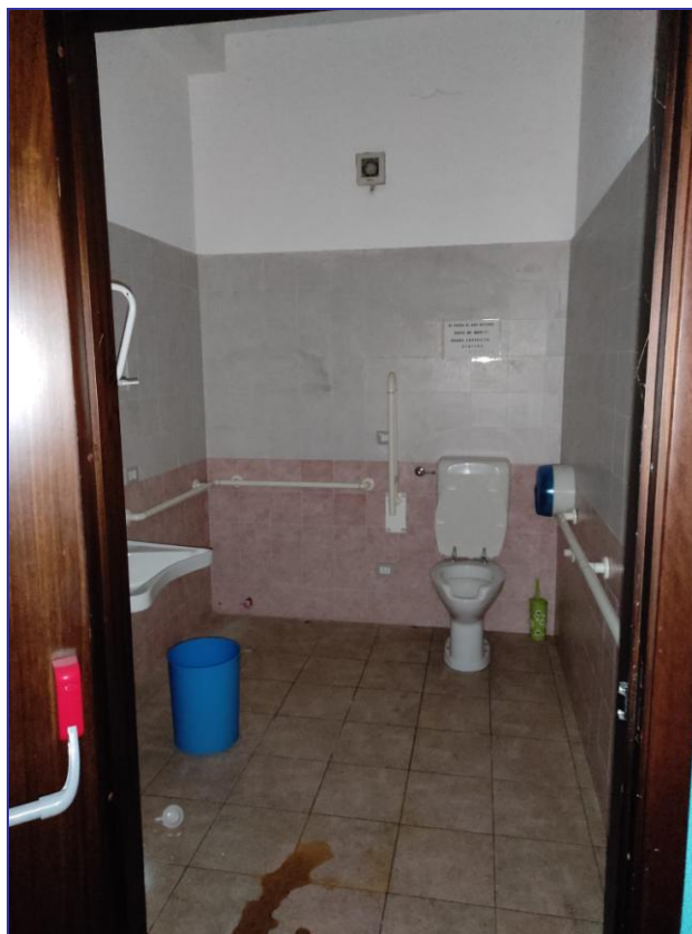
Foto 37 – Imm. 3 – Bagno per disabili.
