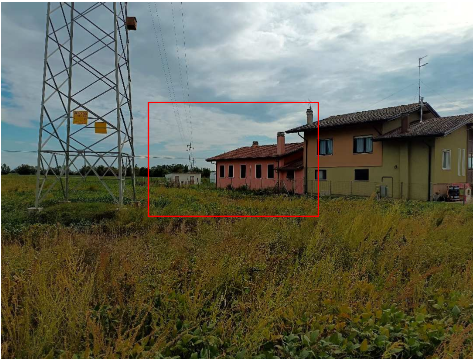
FOTO 1: Vista immobile oggetto di stima da Via Pascoli
