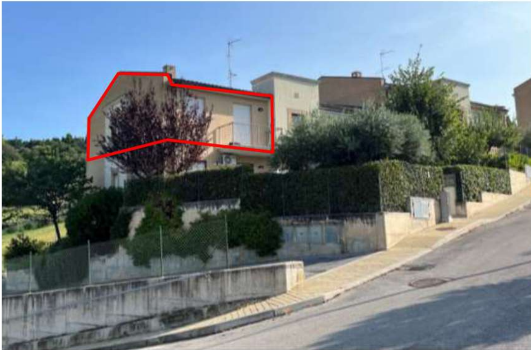
FOTO 6: VISTA DA SUD-OVEST DELL'EDIFICIO CON RAMPA CARRABILE PER GARAGE
