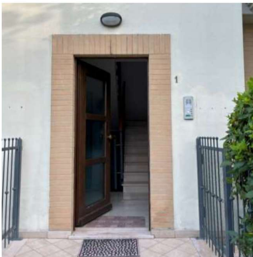
FOTO 12: PARTICOLARE INGRESSO E SCALA DI DISTRIBUZIONE INTERNA
