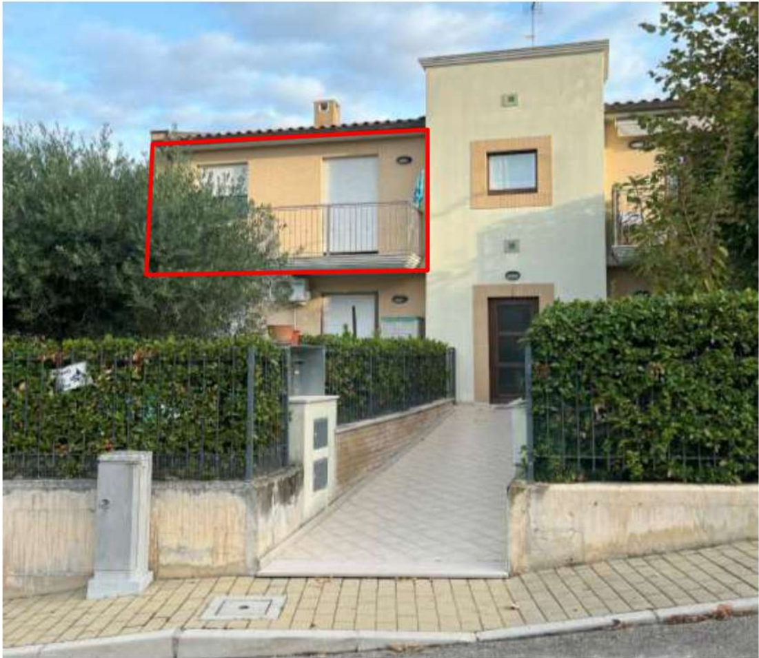
FOTO 10: PARTICOLARE DELL'INGRESSO PEDONALE ALL'EDIFICIO
