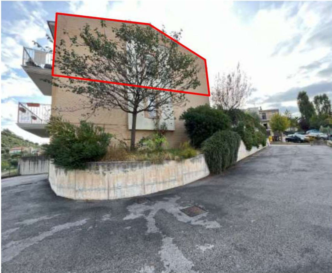
FOTO 8: RAMPA CARRABILE DI ACCESSO AI GARAGE - VISTA PROSPETTO OVEST
