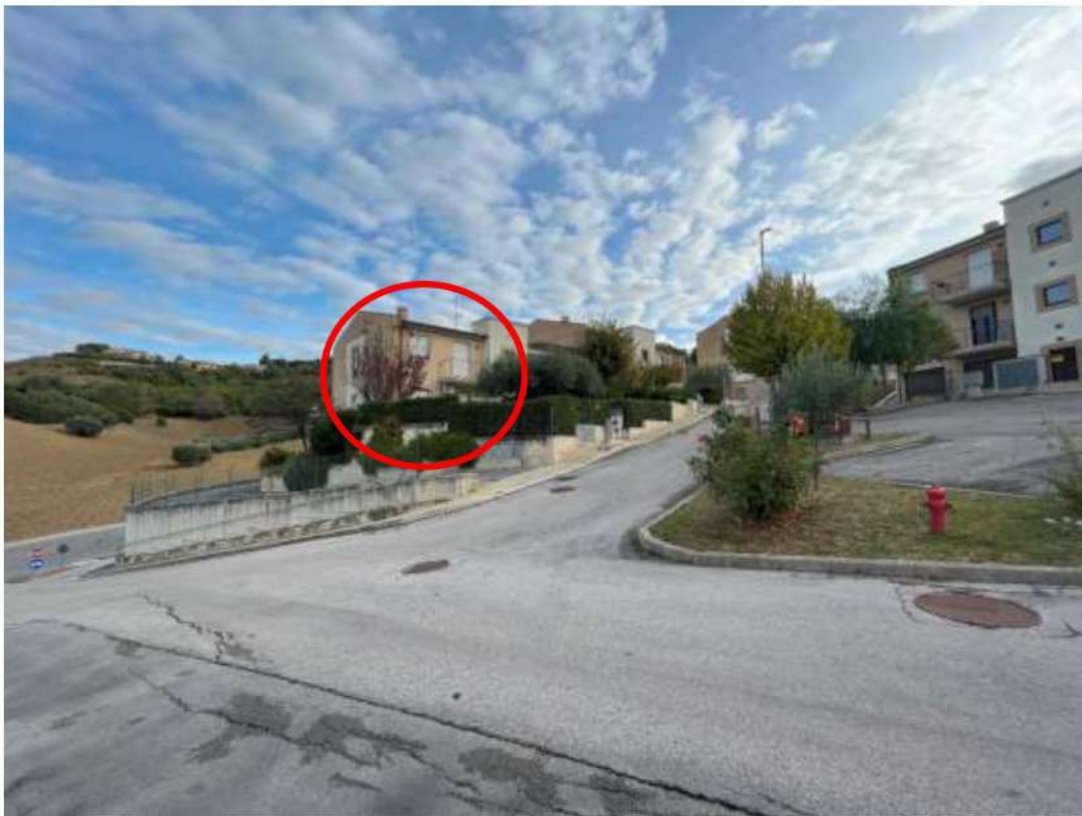
FOTO 2: ACCESSO ALLA LOTTIZZAZIONE ED EDIFICIO IN OGGETTO-VISTA DA SUD
