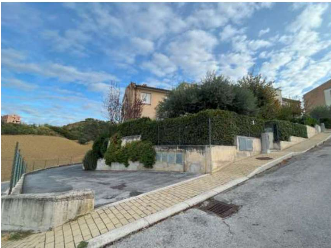
FOTO 7: ACCESSO ALLA RAMPA CARRABILE PER IL PIANO SEMINTERRATO
