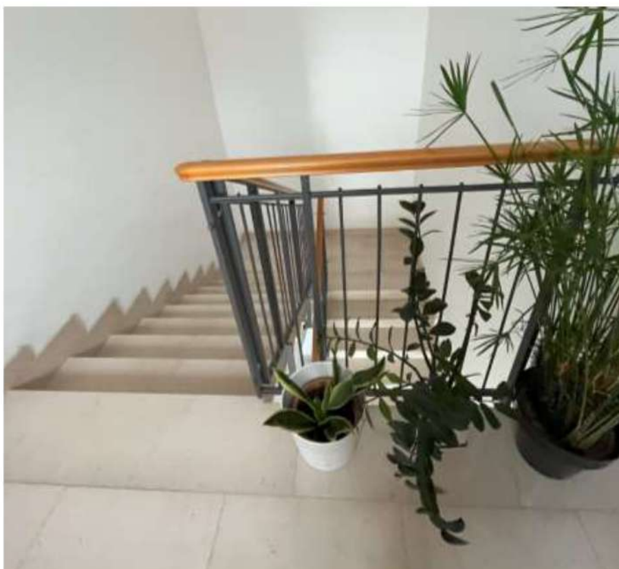
FOTO 14: SCALA DI DISTRIBUZIONE DAL PIANEROTTOLO DEL PRIMO PIANO
