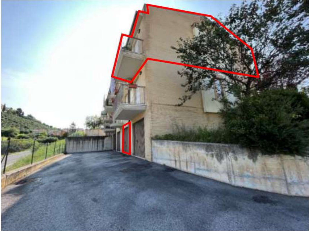
FOTO 4: VISTA PROSPETTO NORD-OVEST
