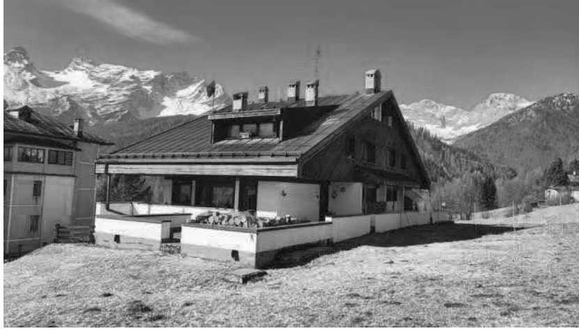
Vista da nord
