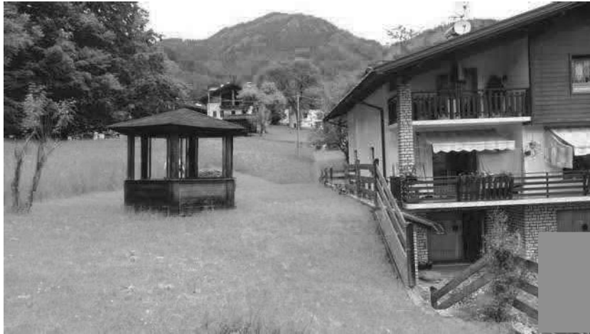
Vista terreno sopra autorimessa
