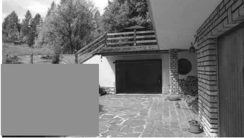
Vista ingresso autorimessa
