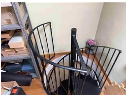
collegamento locale sgombero
