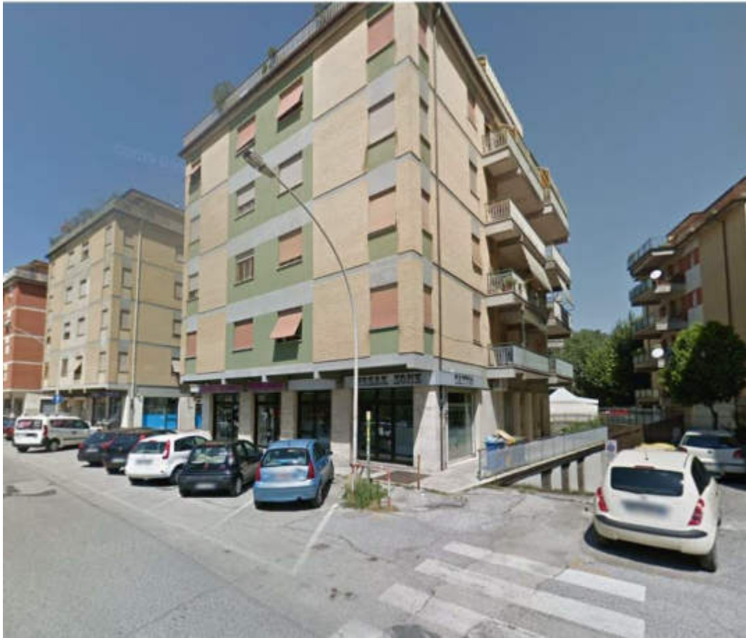
Foto 3 – Ingresso pedonale e carrabile su via Paolessi
