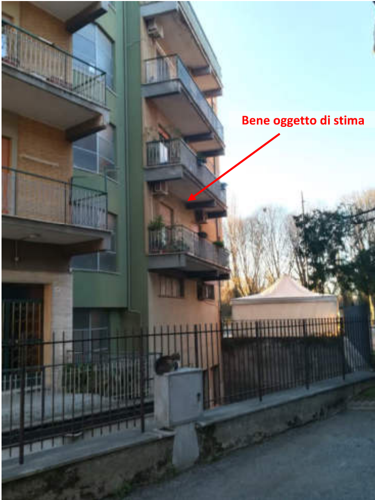
Foto 4 – Prospetto nord-est, vista portone di accesso
