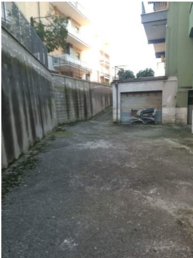
Foto 7 e 8 – Vista ingresso cantina
