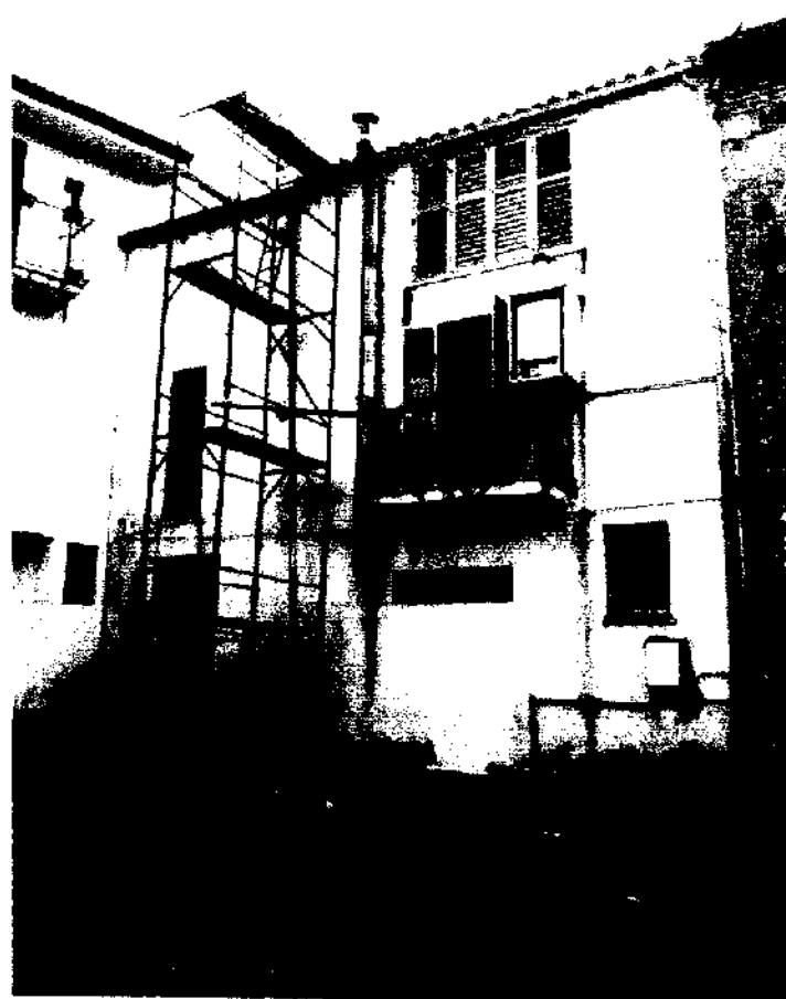
Impalcatura per sistemazione tetto per infiltrazioni meteoriche
