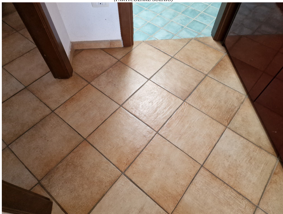
(PARTICOLARE PAVIMENTAZIONE PRESUMIBILMENTE COTTO/GRES)
