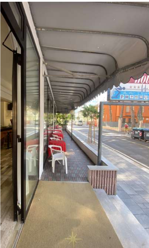
FOTO 12: Terrazza a sbalzo a piano terra
