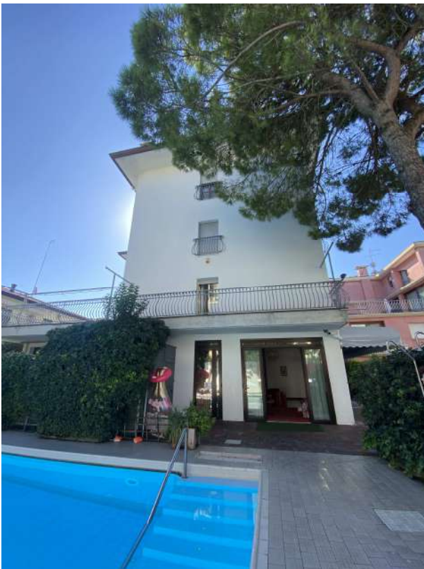
FOTO 4: Vista dalla piscina, fronte Nord
