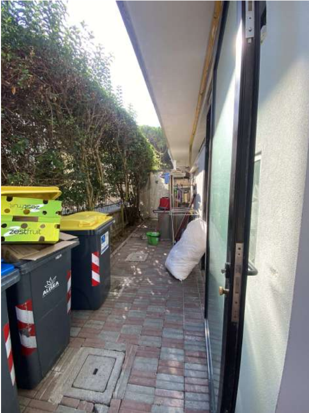
FOTO 7: Vista lato Est del fabbricato
