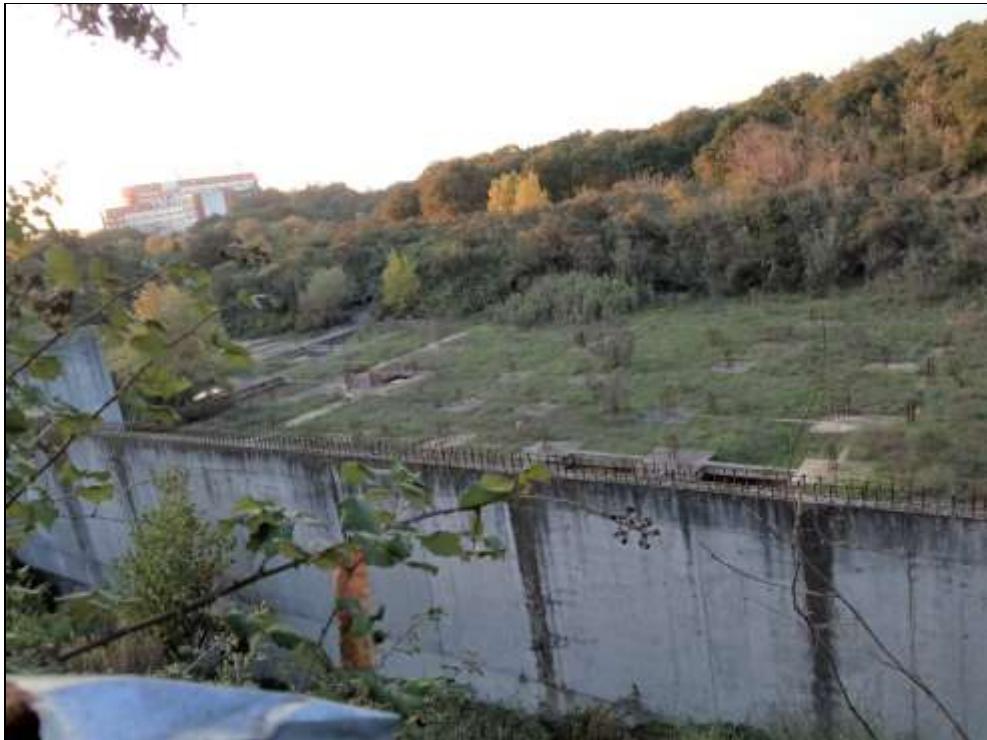
Vista interna delle opere di contenimento e fondazione realizzate
