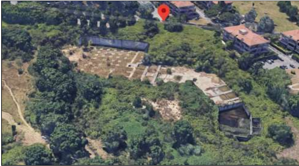
Altra vista delle opere di contenimento e fondazione realizzate
