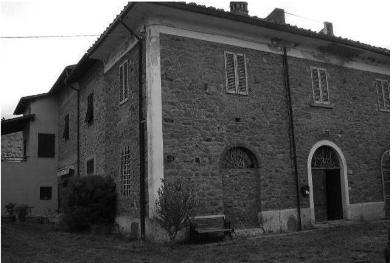
Vista esterna fabbricato
