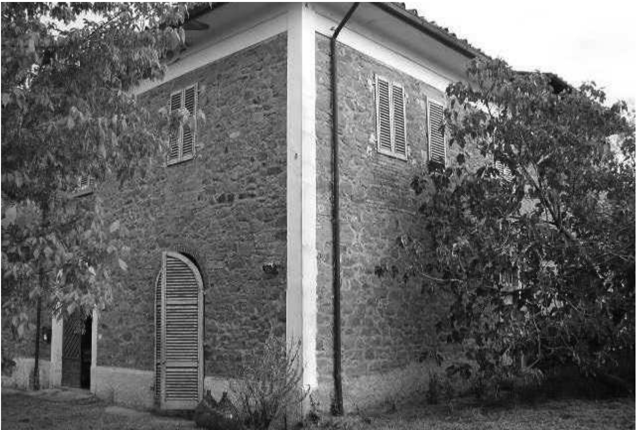
Vista esterna fabbricato
