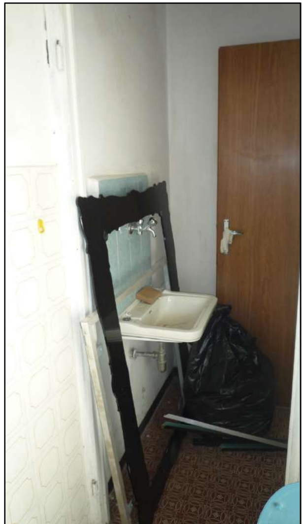
Vista dell'antiwc opposta rispetto la fotografia 11- Fotografia 12
