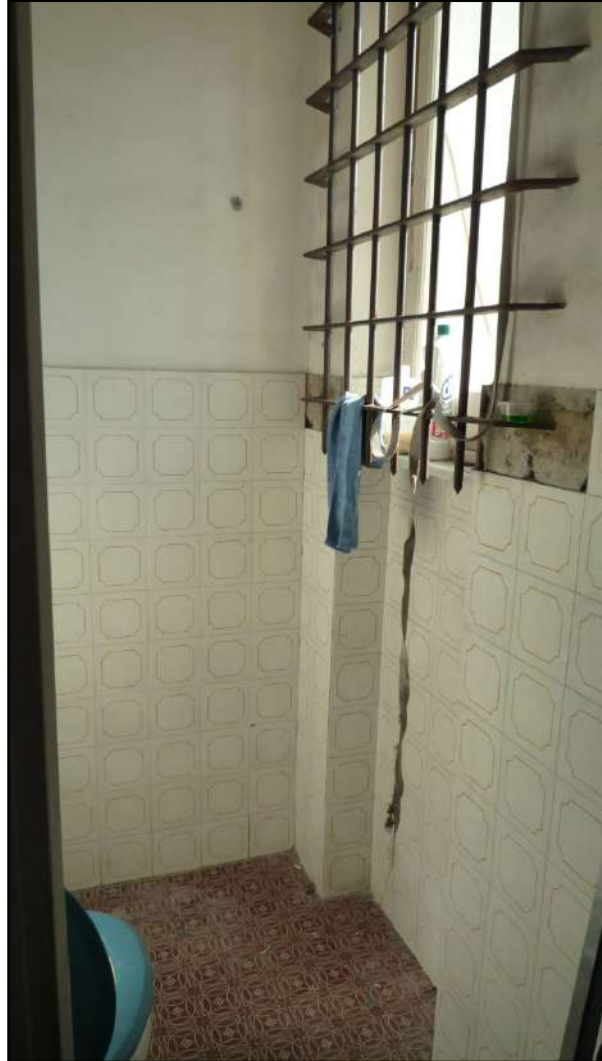
Vista del locale wc- Fotografia 13
