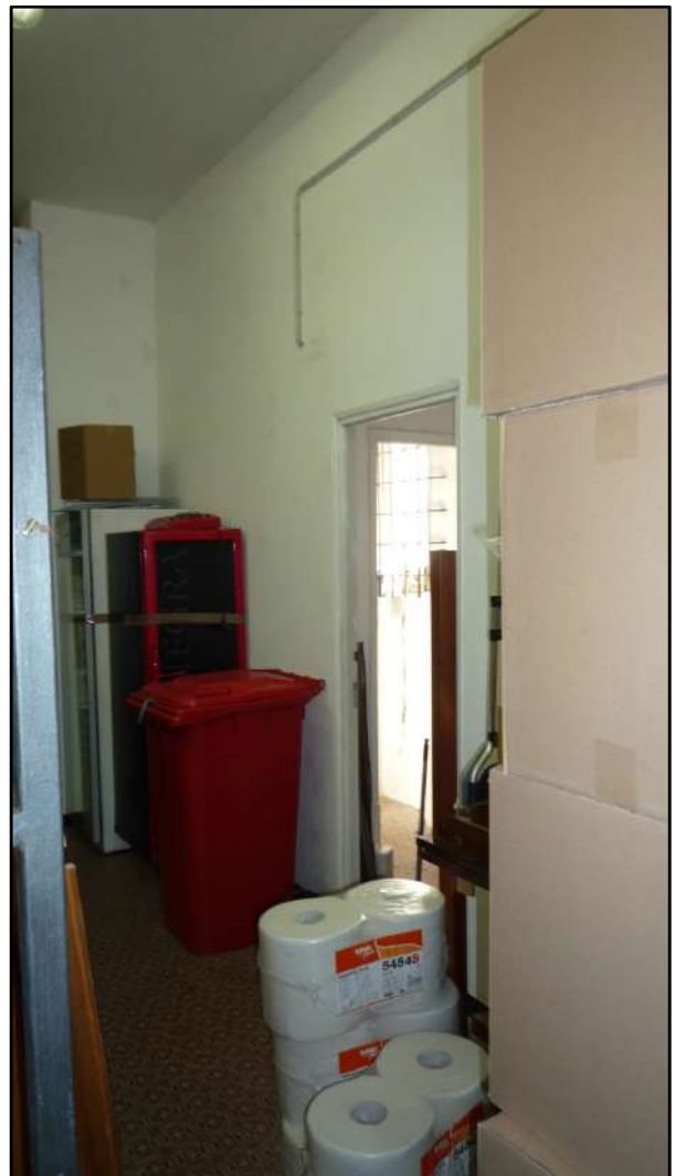
Vista dell'ingresso dell'antibagno - Fotografia 10
