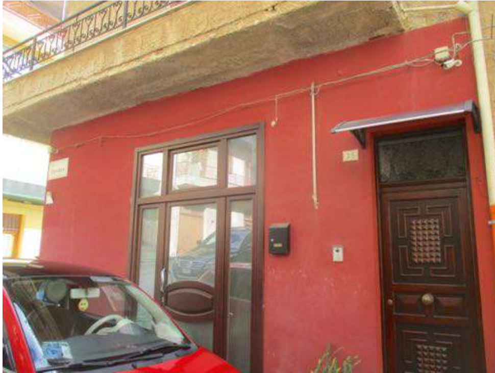
Foto 1-2 vista del fabbricato sito in San Giuseppe Jato (Pa) via Canepa 35
