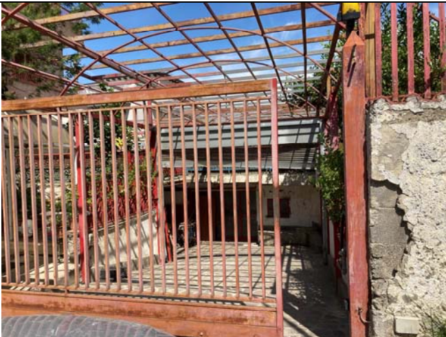
Ingresso carrabile ai locali deposito (abusivi) e garage (sub 38) .
