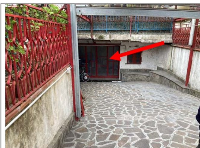
Rampa di accesso al garage piano seminterrato p.lla 910 sub 38, con vista locale abusivi.
