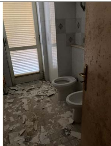
Bagno 1: abitazione piano rialzato p.lla 910 sub 19.
