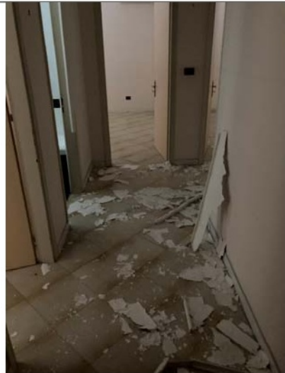
Corridoio: abitazione piano rialzato p.lla 910 sub 19.
