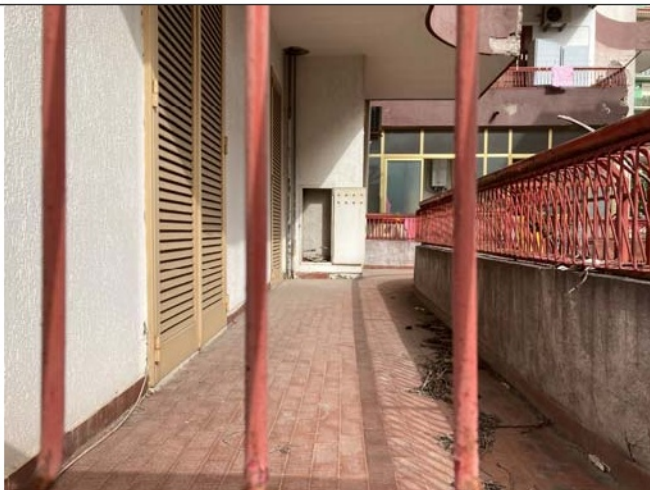
Balcone: abitazione piano rialzato p.lla 910 sub 19.
