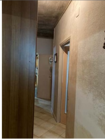
Corridoio: abitazione piano rialzato p.IIa 910 sub 18.
