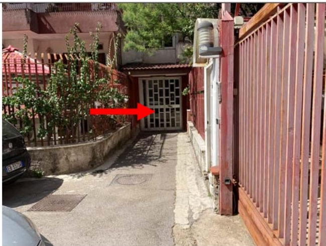
Ingresso al fabbricato da corte comune.
