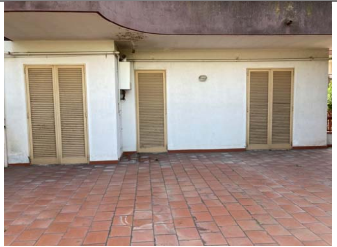
Terrazzo : appartamento (sub19) piano rialzato.
