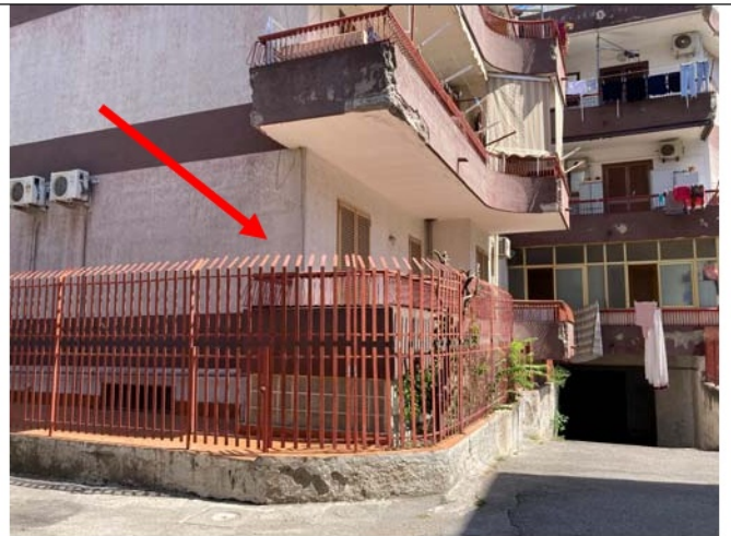
Prospetto d'angolo del fabbricato traversa via Corallo/via S. Rocco: appartamento (sub19) piano rialzato.
