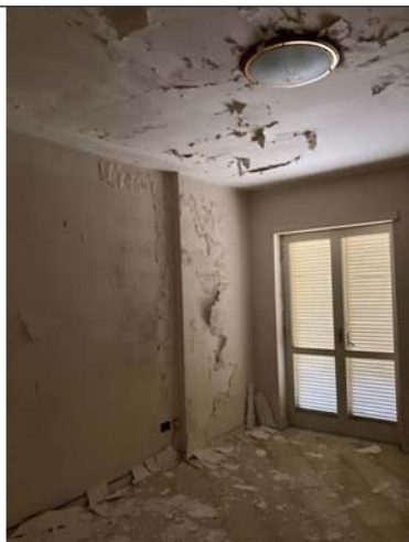
Camera 4: abitazione piano rialzato p.lla 910 sub 19.
