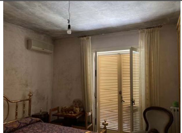
Camera 3: appartamento (sub18) piano rialzato.
