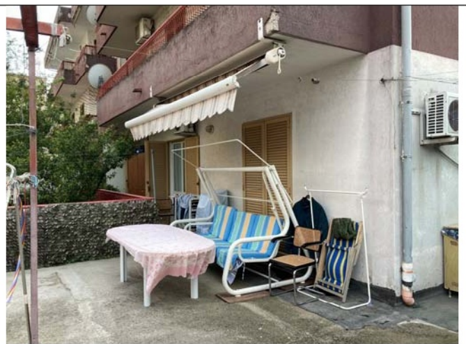
Balcone con terrazzo abusivo: abitazione piano rialzato p.IIa 910 sub 18.
