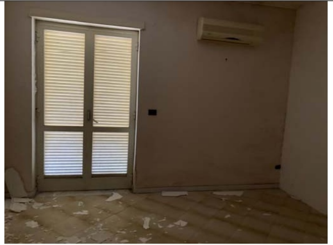
Camera 1: abitazione piano rialzato p.lla 910 sub 19.
