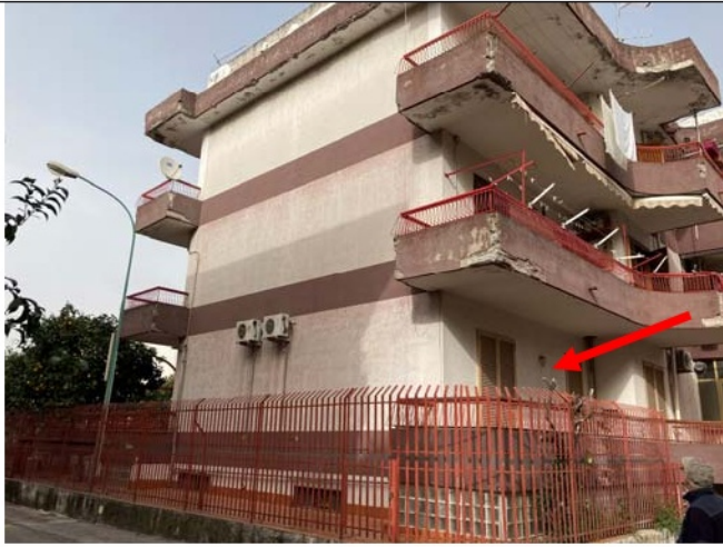
Prospetto posteriore fabbricato via Corallo – trav. S. Rocco Pagani (SA); abitazione piano rialzato p.lla 910 sub 19.
