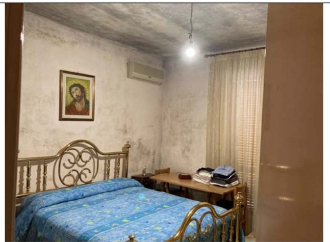
Camera 1: abitazione piano rialzato p.lla 910 sub 18.
