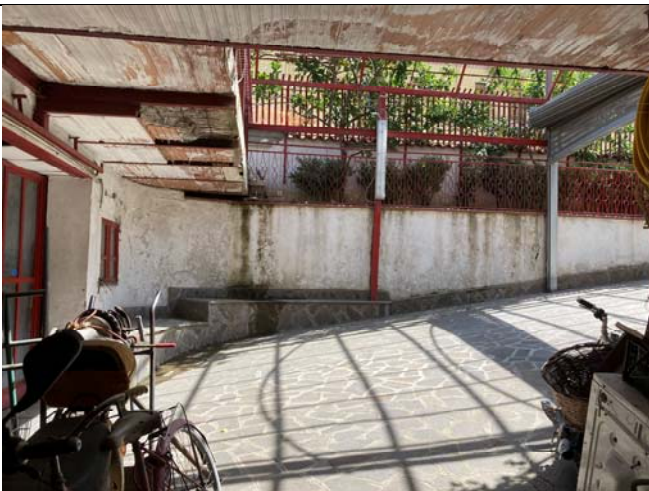
Rampa carrabile di accesso ai locali deposito (abusivi) e garage (sub 38) .
