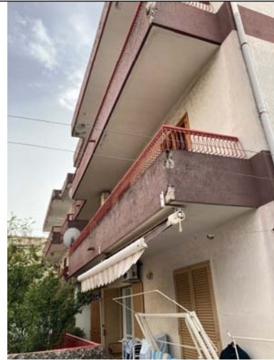
Prospetto principale fabbricato via Corallo – trav. S. Rocco Pagani (SA); abitazione piano rialzato p.lla 910 sub 18.
