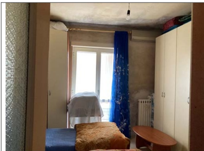
Camera 2: abitazione piano rialzato p.lla 910 sub 18.
