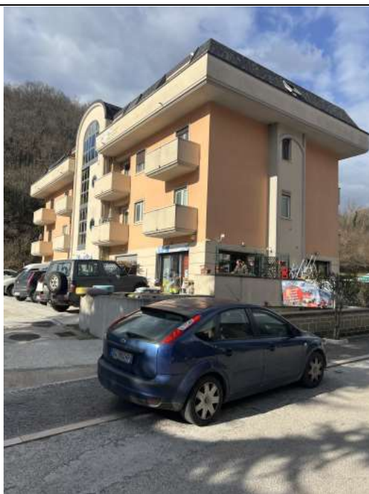
(foto 1: prospetto principale)
