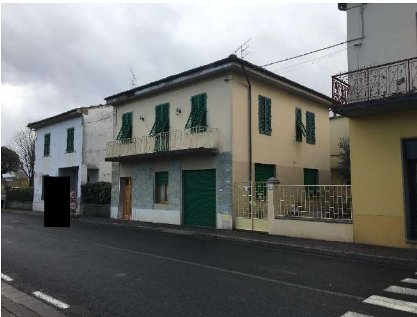
Vista da via Dante Alighieri
