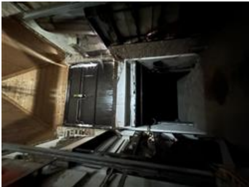
Vista da dentro con veduta della basculante a piano terra e del magazzino al piano interrato
