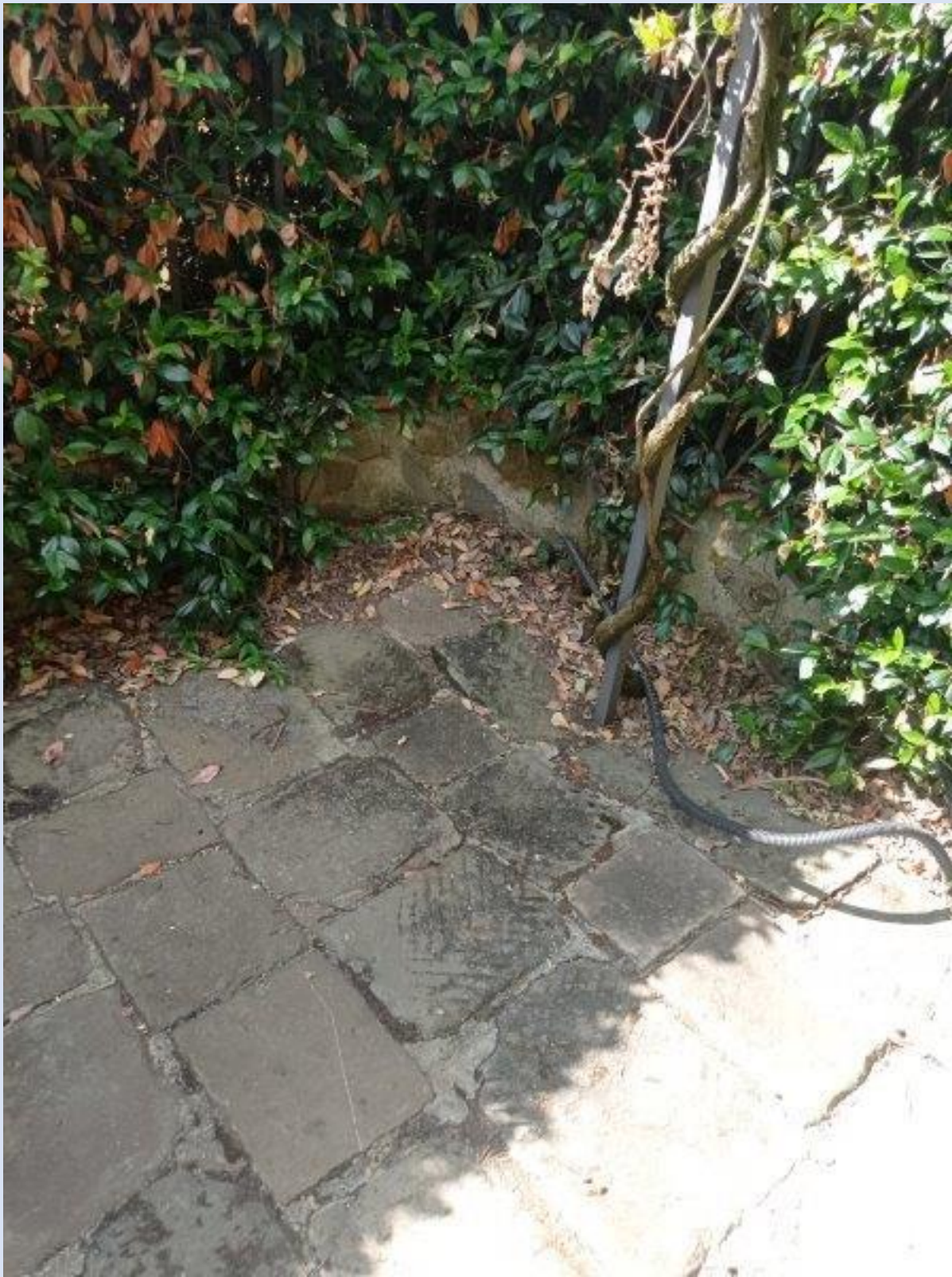
FIGURA 14 PARTICOLARE AFFOSSAMENTO RESEDE TERGALE
