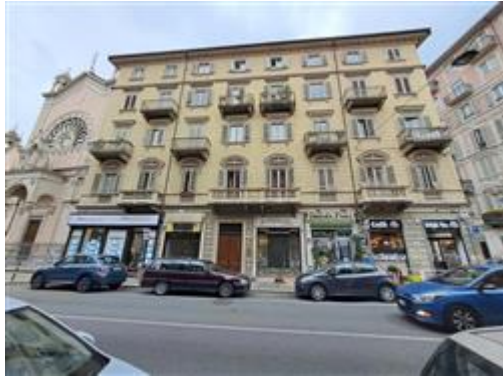
Facciata su Via San Donato
