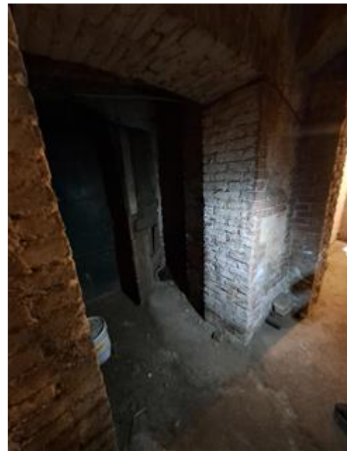
Locale cantina nell'interrato
