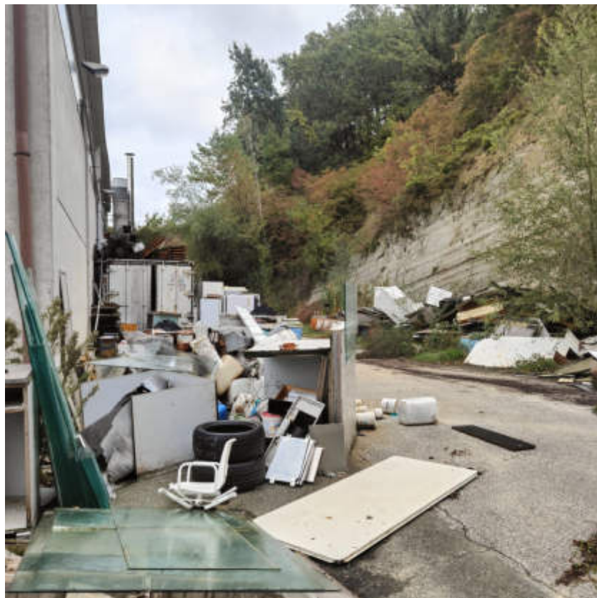
Vista esterna della porzione di corte pertinenziale posta sul fronte Est degli accumuli di scarti delle lavorazioni
