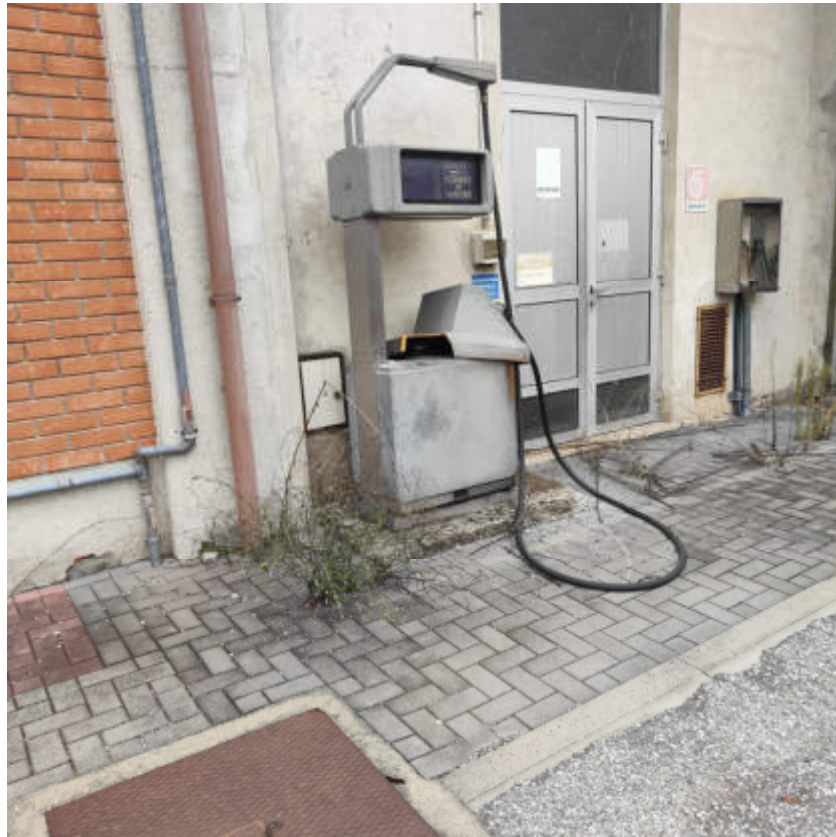
Vista esterna distributore carburante con botola di accesso alla cisterna interrata
