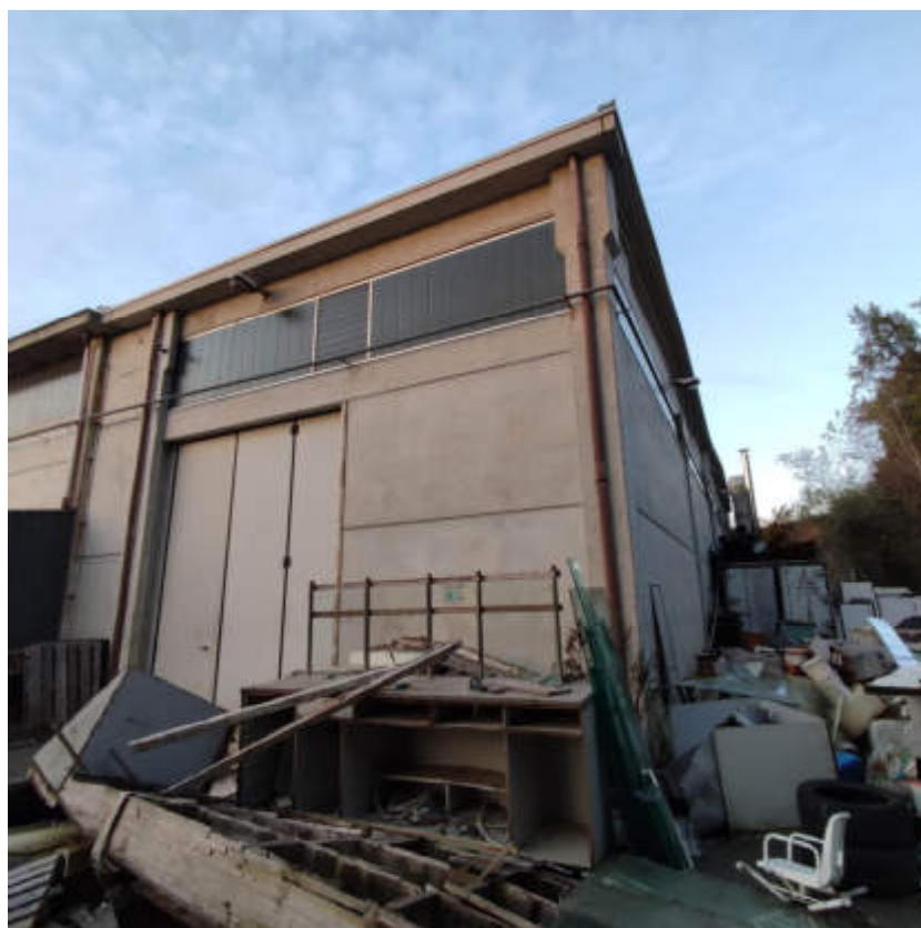
Vista laterale fronte Est e risvolto fronte Nord della porzione di fabbricato produttivo
