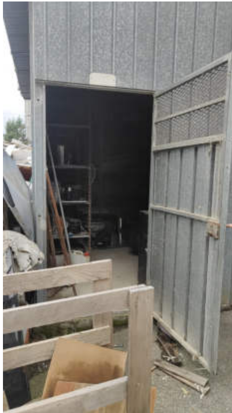
Vista esterna del piccolo prefabbricato in lamiera addossato sul fronte Sud del capannone
