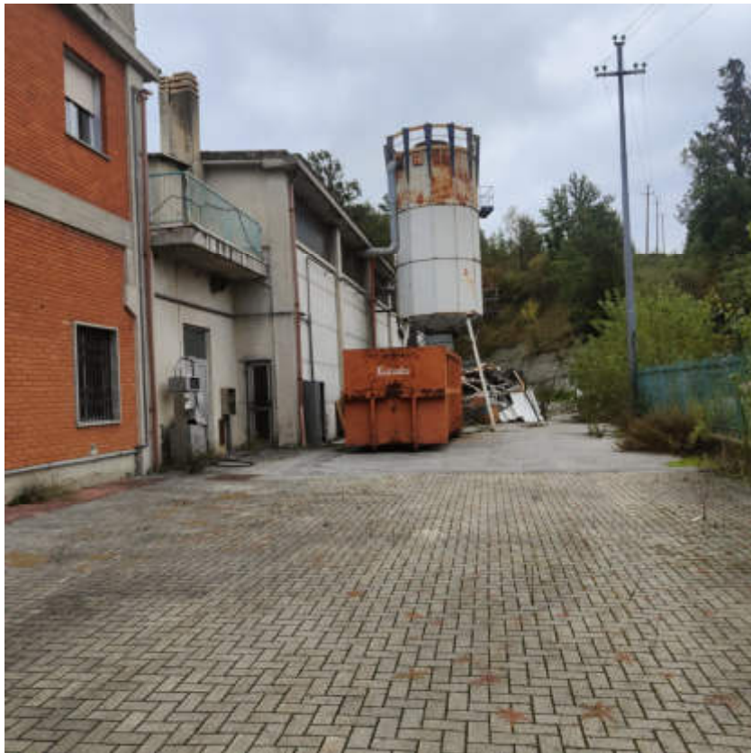
Vista laterale fronte Sud della porzione di fabbricato produttivo e area scoperta pertinenziale
