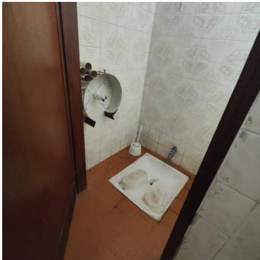
Vista interna della zona bagno / spogliatoio dipendenti
