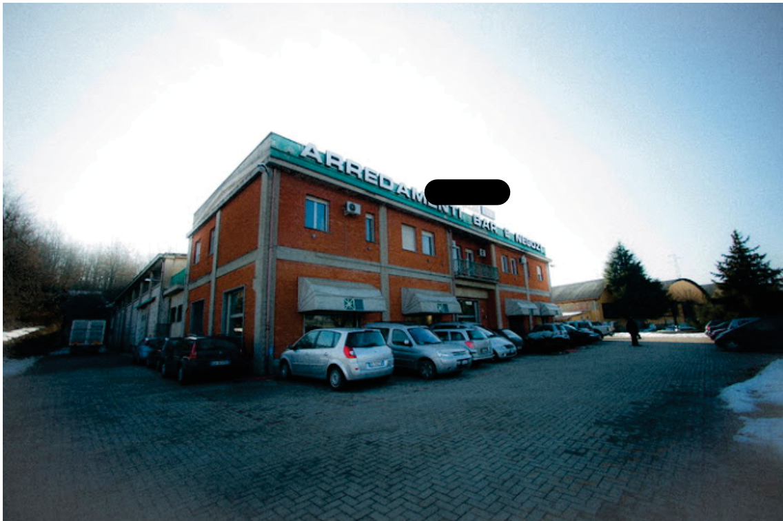
Fig. 5 – Immagine di repertorio del fronte della palazzina e del capannone produttivo alle spalle
