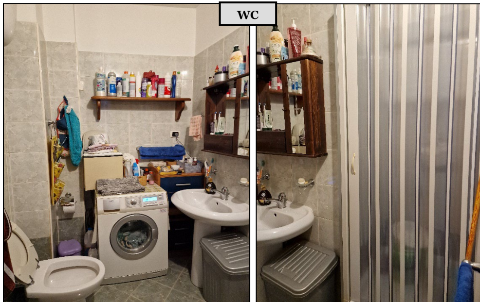
Foto 22-23: viste dell' unico WC , senza finestratura e con box doccia ricavato all'interno di nicchia in muratura.
