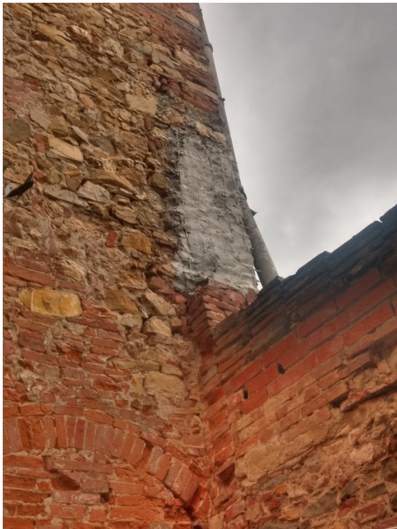
20. Particolare dei lavori di consolidamento svolti
