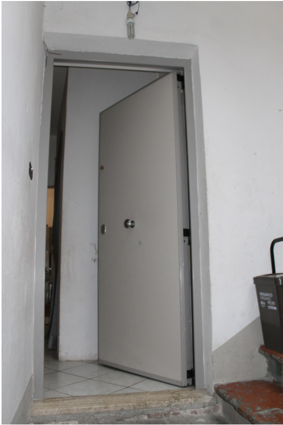
6. Portone d'ingresso all'appartamento dal vano scale condominiale
