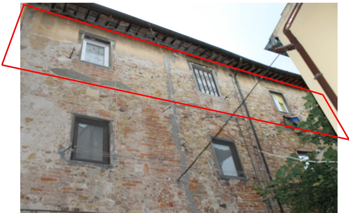
5. Prospetto sud ovest dell'edificio visto dalla corte e individuazione dell'appartamento
