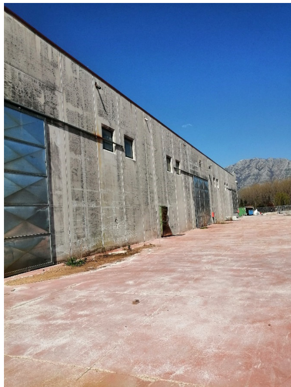
Foto n. 10 – Vista laterale opificio
