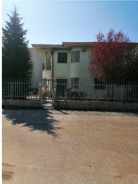
Foto n. 3 – Vista principale uffici
