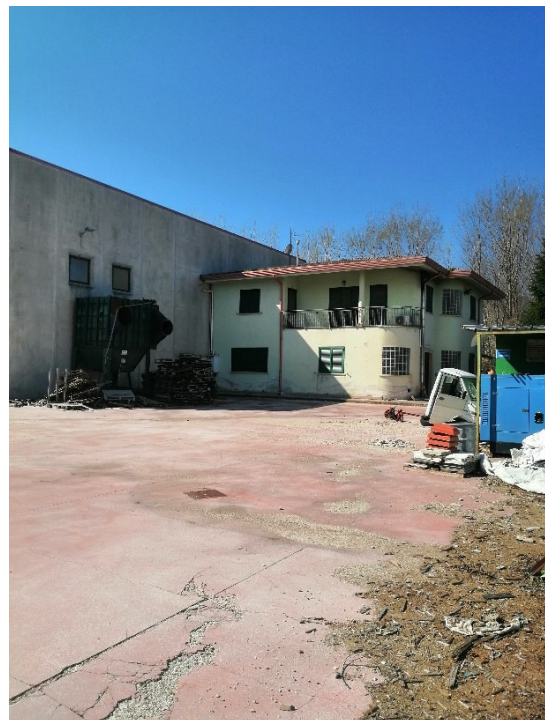
Foto n. 2 – Vista laterale uffici
