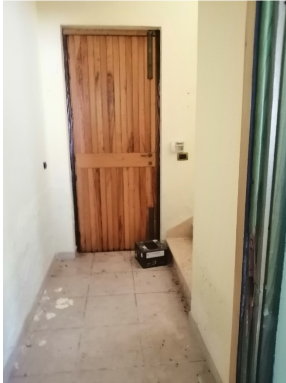
Foto 19 – Vista palazzina uffici P.T. Ingresso laterale
