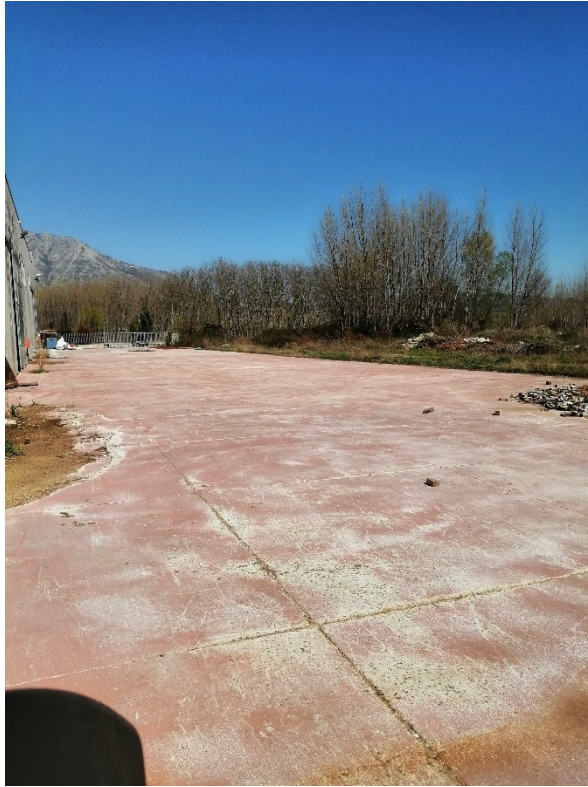
Foto n. 9 – Vista piazzale opificio
