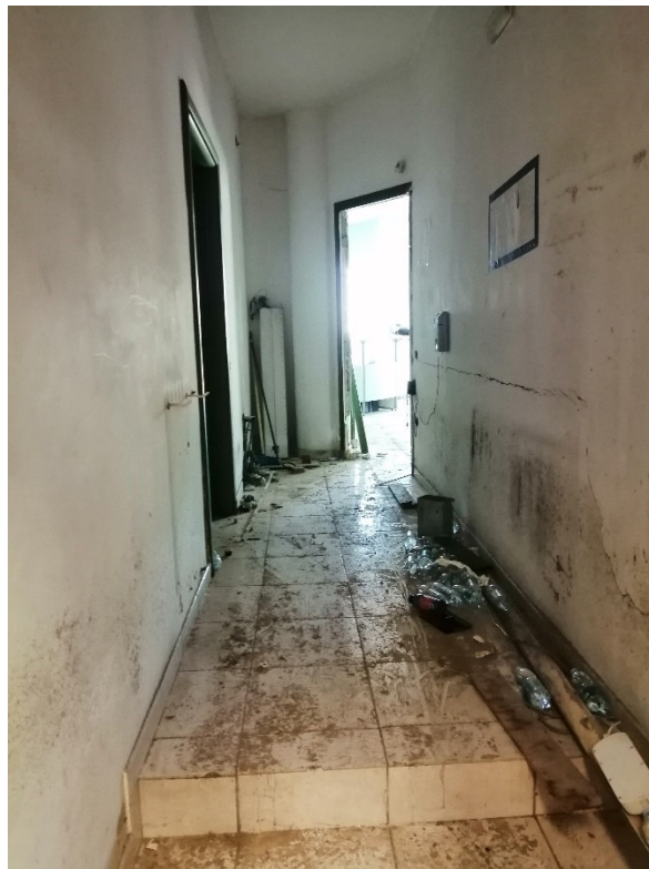
Foto n. 16 – Vista palazzina uffici P.T. Disimpegno
