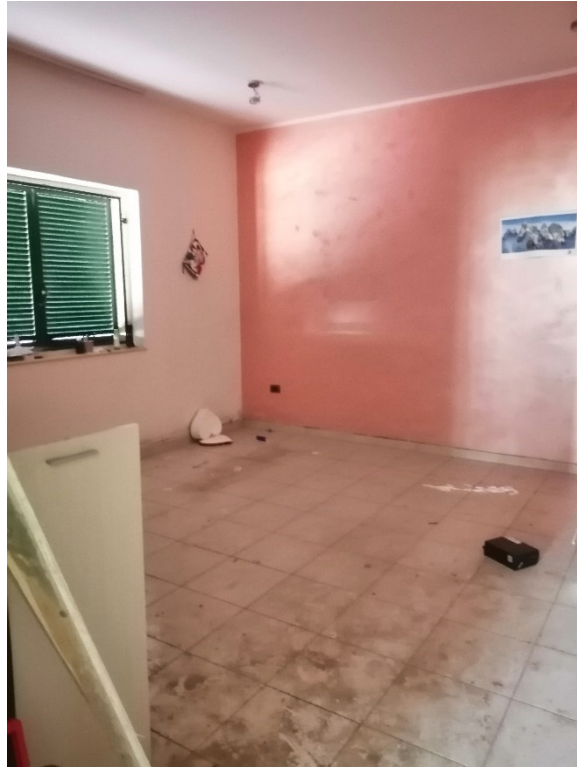
Foto n. 17 – Vista palazzina uffici P.T. Direzione
