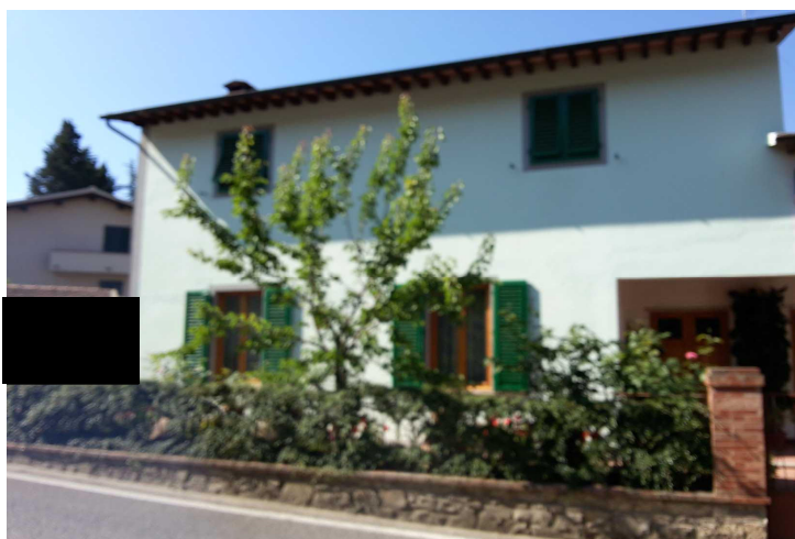
2) Edificio B) visto dalla strada
