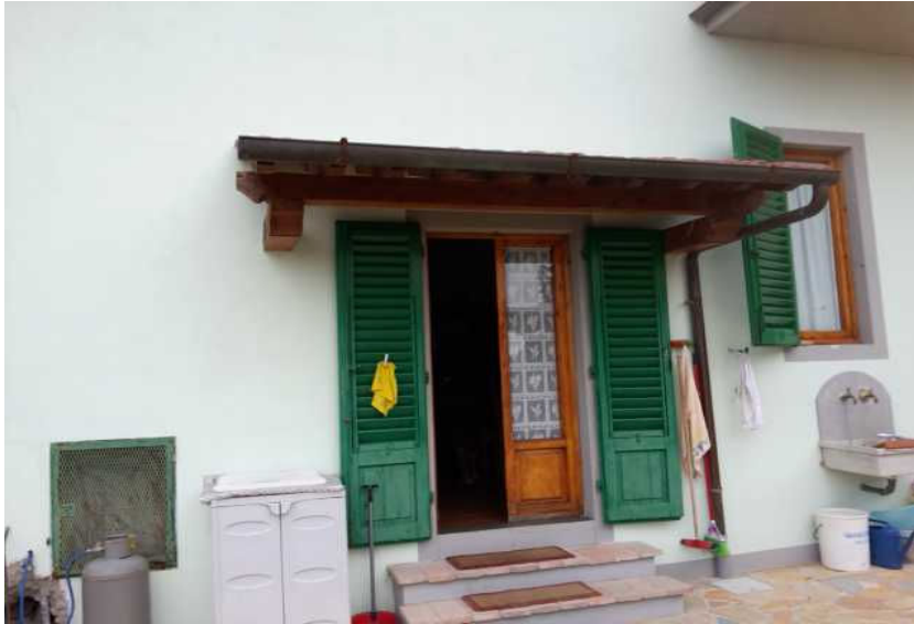
19)Esterno edificio B ( piano terra ) resede tergale
