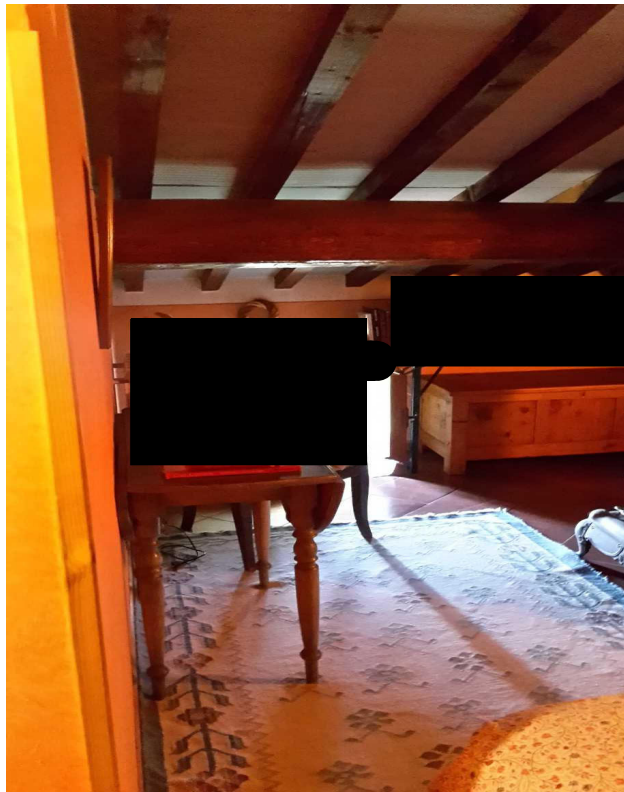
36 )Interno edificio A ( piano soffitta ) porzione utilizzata dal Sig. [REDACTED]
