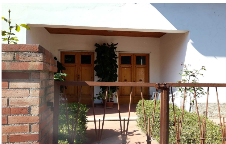
4) L'ingresso dalla strada agli edifici A) e B)
