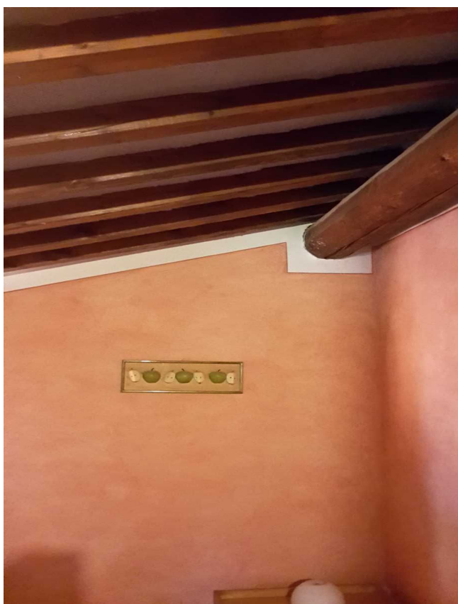
38 )Interno edificio A ( piano soffitta ) porzione utilizzata dal Sig. [REDACTED]
