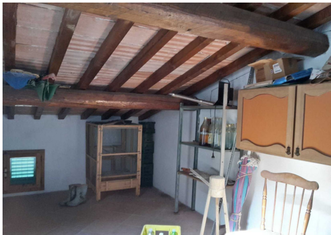
27 )Interno edificio A ( piano primo ) soffitta
