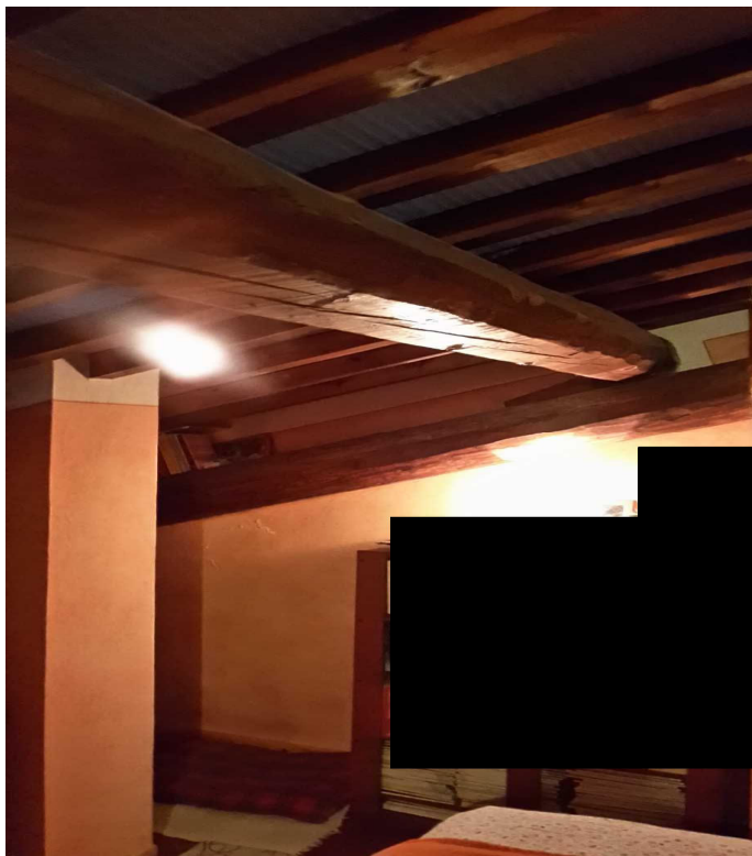
37 )Interno edificio A ( piano soffitta ) porzione utilizzata dal Sig. [REDACTED]
