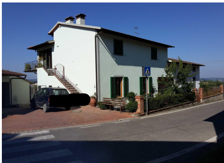
1) Via di Campoli vista dell'intero fabbricato
