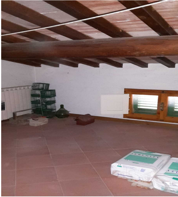
28 )Interno edificio A ( piano primo ) soffitta
