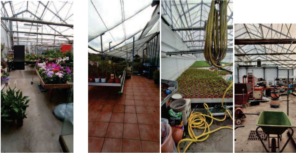
Particella 718 - Interno di più settori della serra
