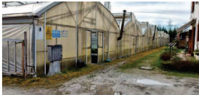
Particelle 714 - 709 – 249 - Serre su lato Nord
