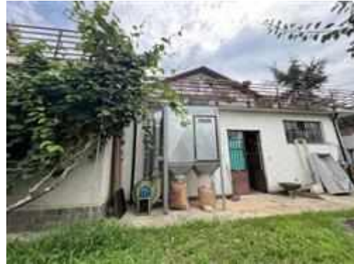
vista del prospetto sull'area esterna pertinenziale ai corpi A e B
