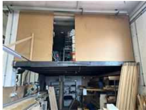
vista del piccolo soppalco realizzato all'interno del capannone
