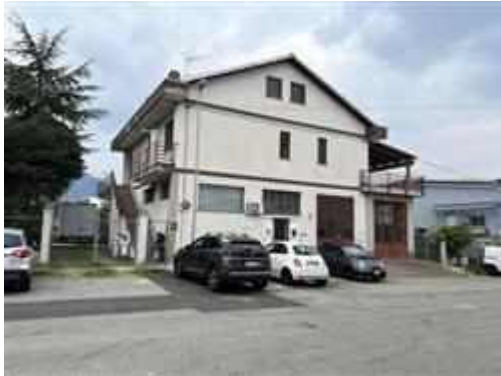
vista della facciata verso la via Fermi
