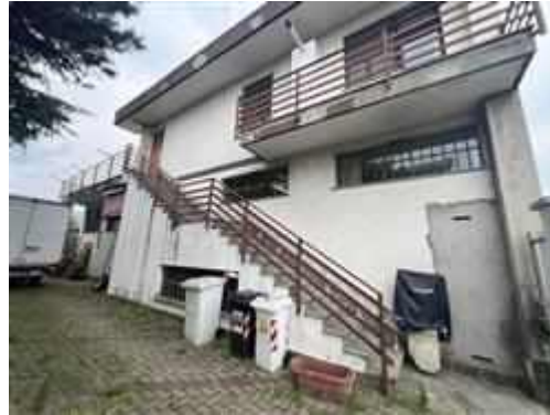
vista del prospetto sud verso l'area esterna pertinenziale in comune con il corpo A
