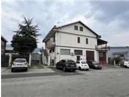
vista del prospetto sulla via Fermi
