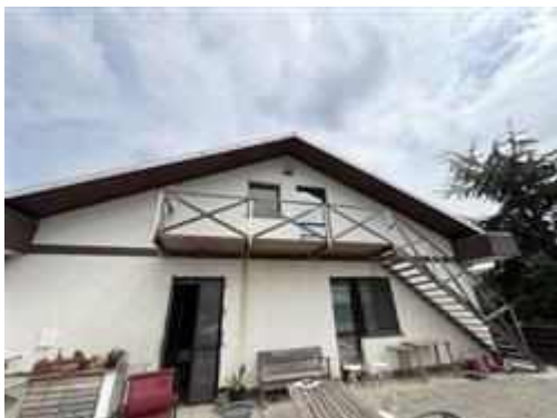
particolare della scala e pianerottolo esterni di accesso al piano sottotetto
