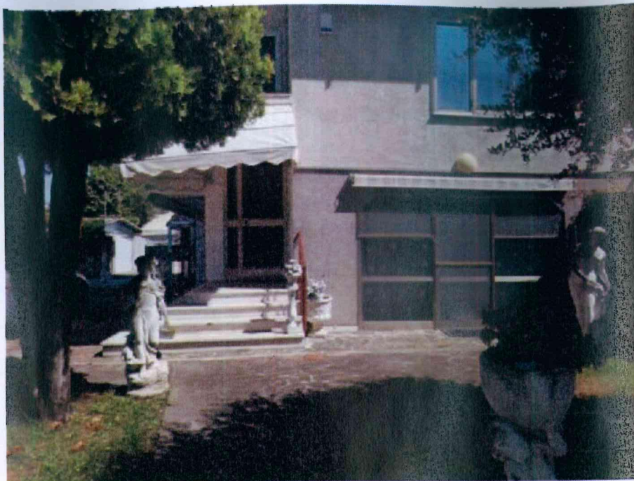
ACCESSO AL VANO SCALA PIANO TERRA
