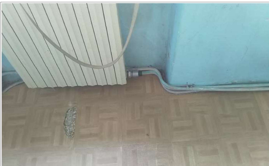
Particolare dei caloriferi e del precario sistema di collegamento delle tubazioni
