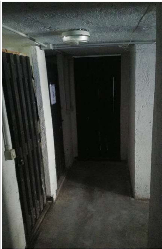
Il corridoio comune del piano interrato cantine
