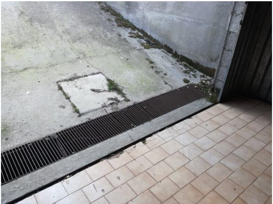
Foto 10: griglia e pozzetto perdente
