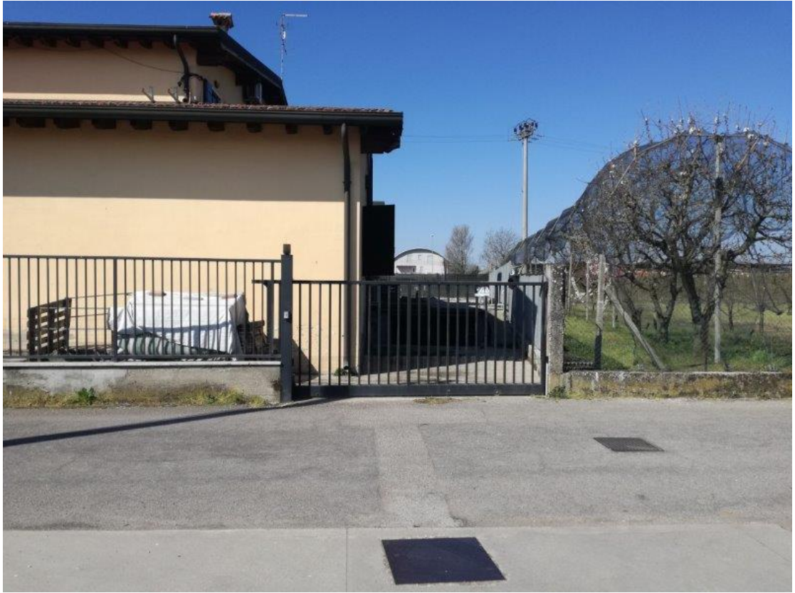
Foto 19: vista ingresso da via Zambonina
