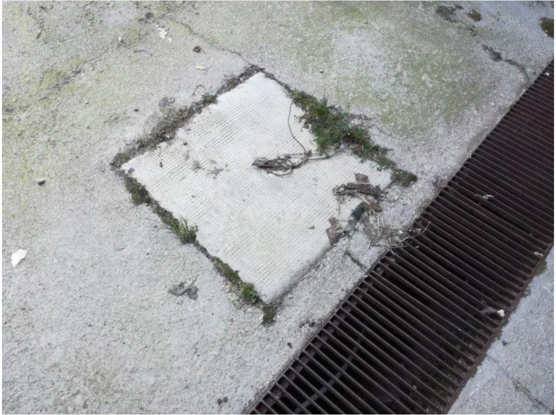
Foto 13: particolare smaltimento acqua
