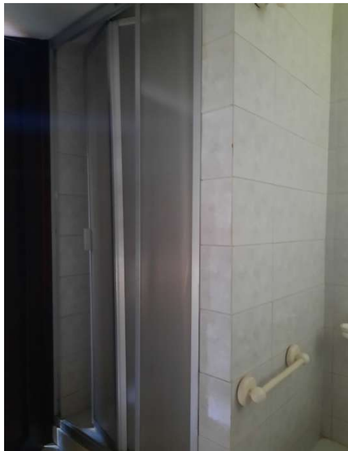
Foto n. 41 – bagno: doccia in muratura
