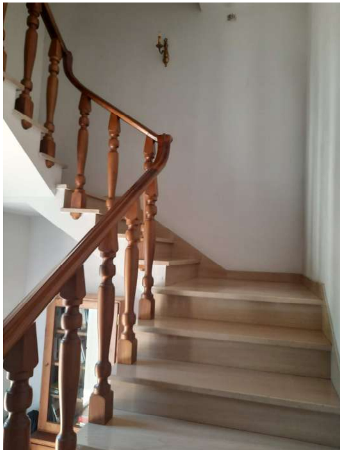
Foto n. 7 – Vano scala tra piano terra e piano primo
