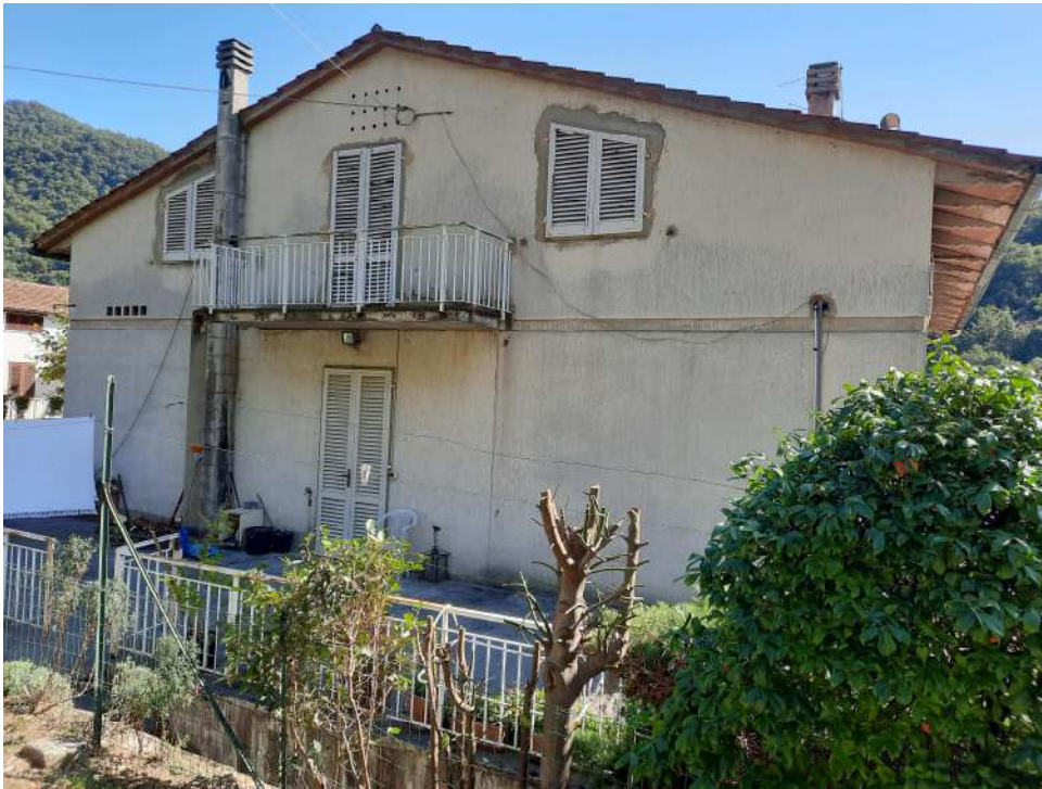
Foto n. 3 – Prospetto sul retro
