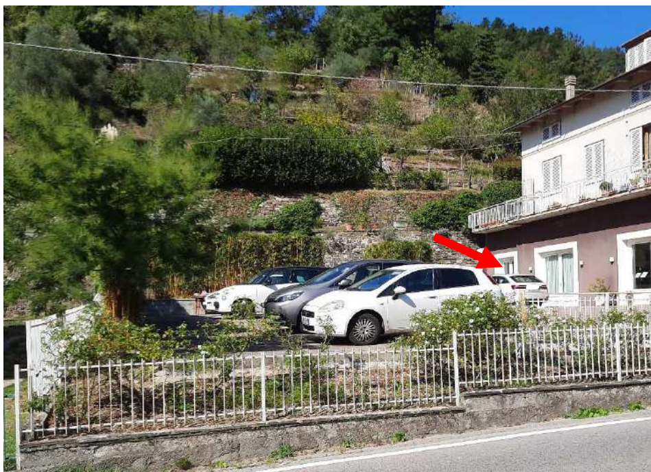
Foto n. 4 – Resede a comune e indicazione del punto di accesso alla cantina con passaggio all'interno di altra unità immobiliare
