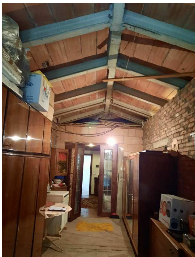
Foto n. 45 – soffitta con accesso al balcone
