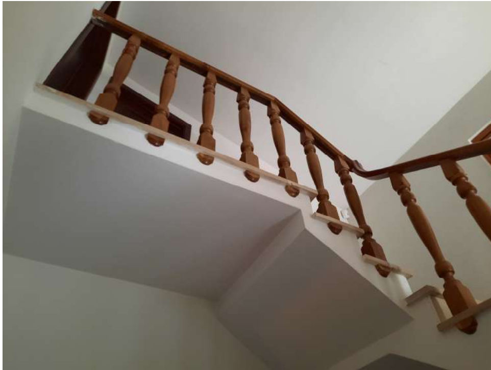
Foto n. 30 – Vano scala piano soffitta
