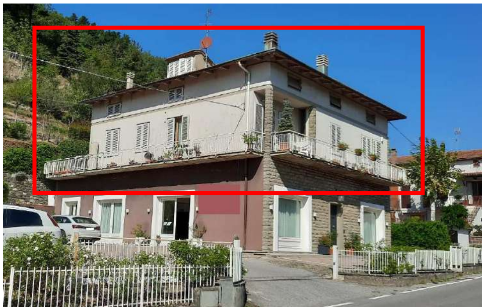
Foto n. 1 -Vista del fabbricato e individuazione dell'unità immobiliare
