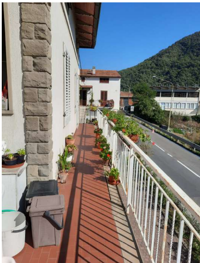
Foto n. 14 – balcone prospiciente via Bologna (SR325)
