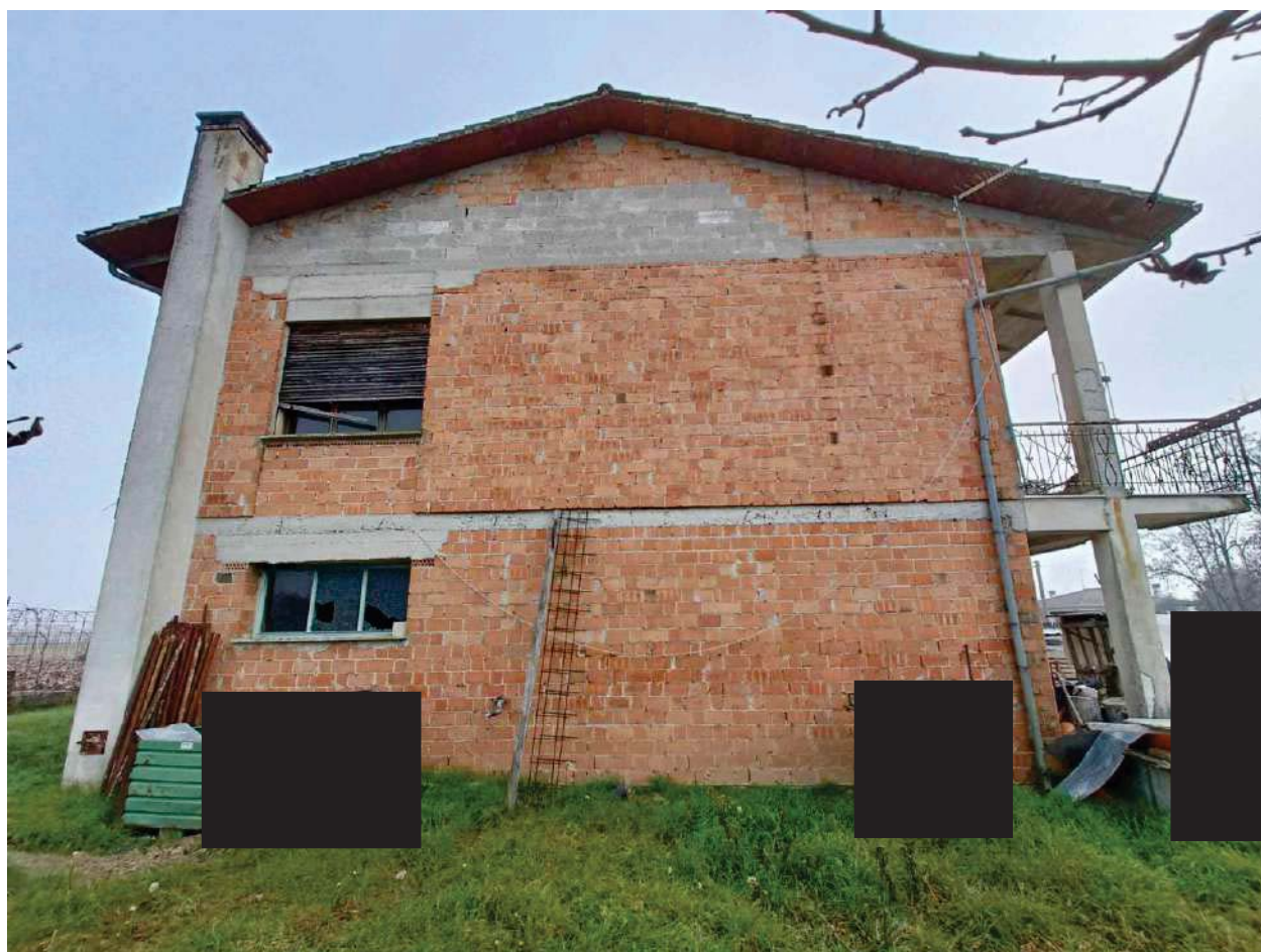
Foto 2 – Sub. 1-2:, prospetto ovest
