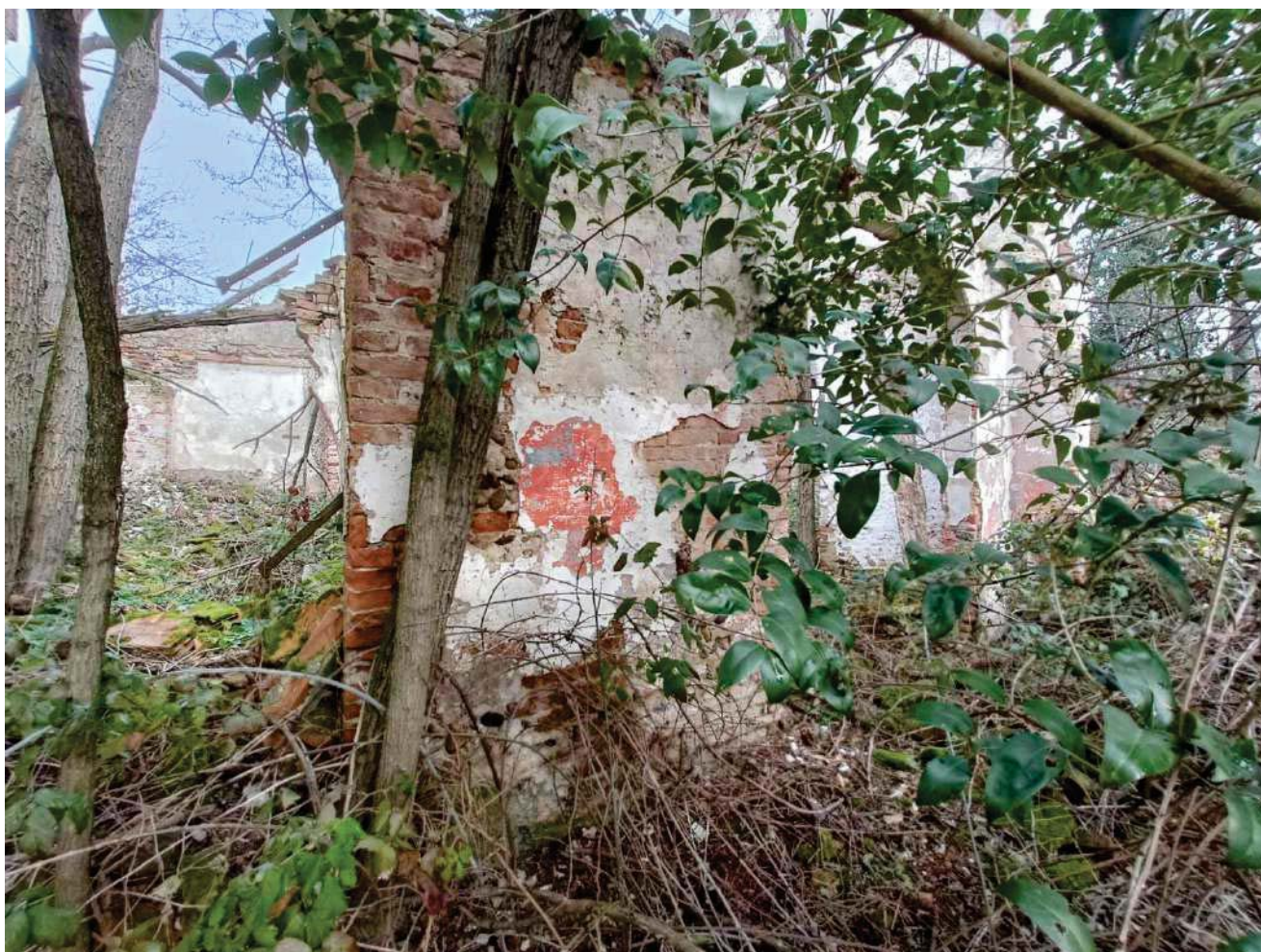
Foto 32 – sub 3: vista lato est
