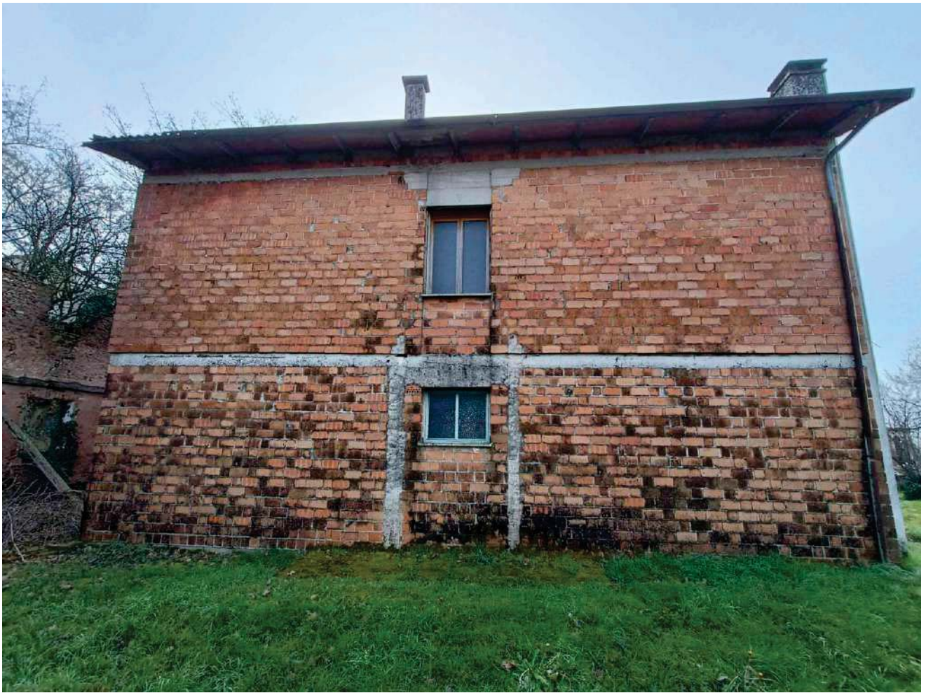
Foto 3 - Sub. 1-2: prospetto nord
