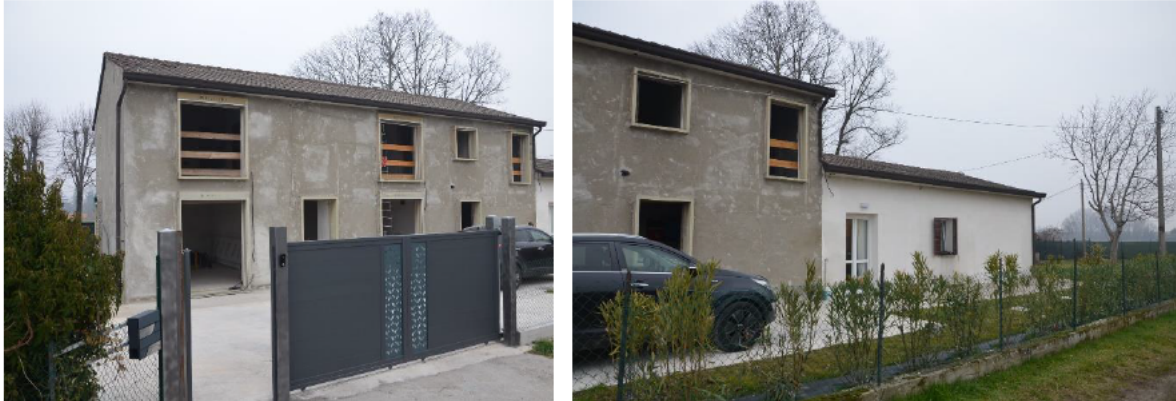
Edificio in corso di ristrutturazione con annesso a Monselice (PD) via Rovigana n. 29 Coord. Google 45°13'12.7"N 11°45'18.7"E
