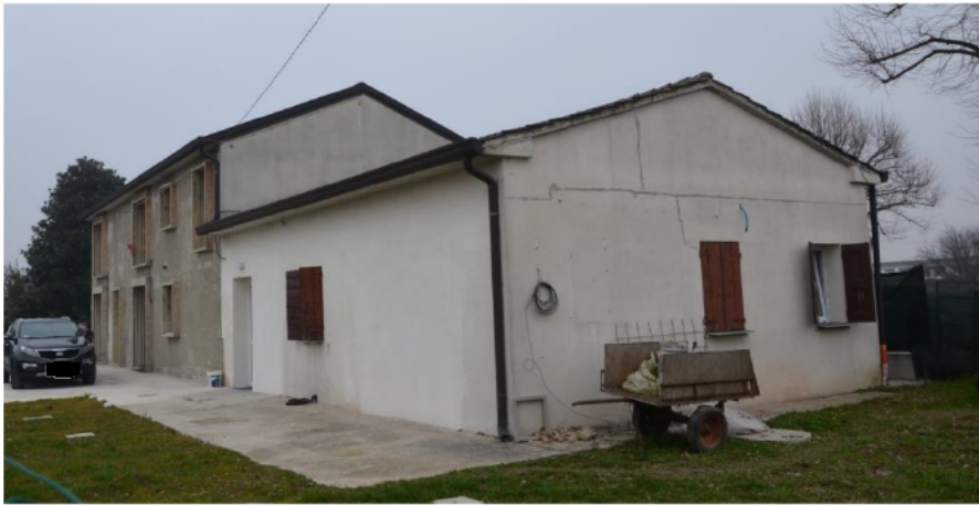
Vista garage lato sud edificio
