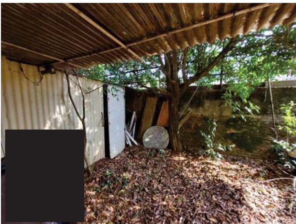
Magazzino e muro sostegno ferrovia
