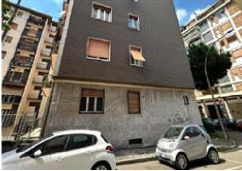
Vista fronte est
