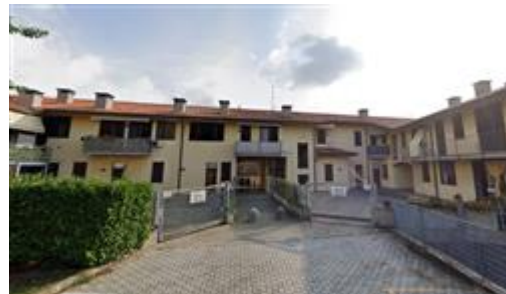
Vista fronte ovest condominiale
