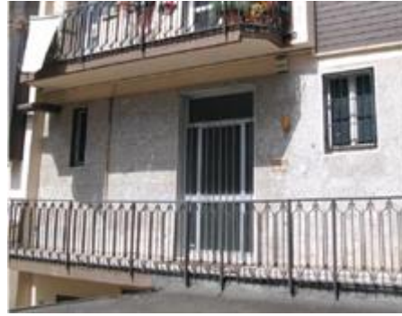
Vista fronte sud
