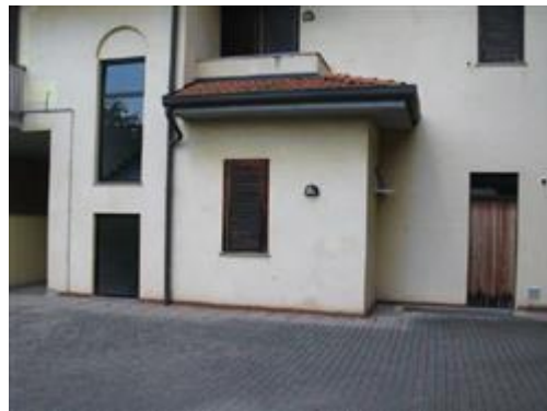
Dettaglio fronte ovest del negozio
