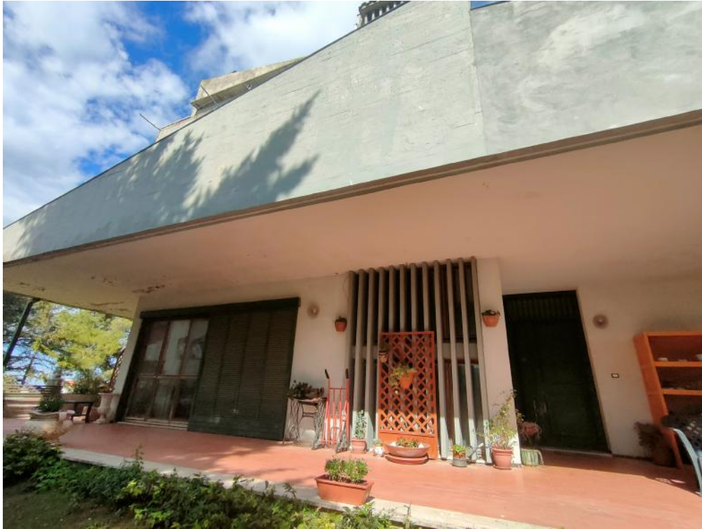
FOTO ACCESSO VILLA P.T.
