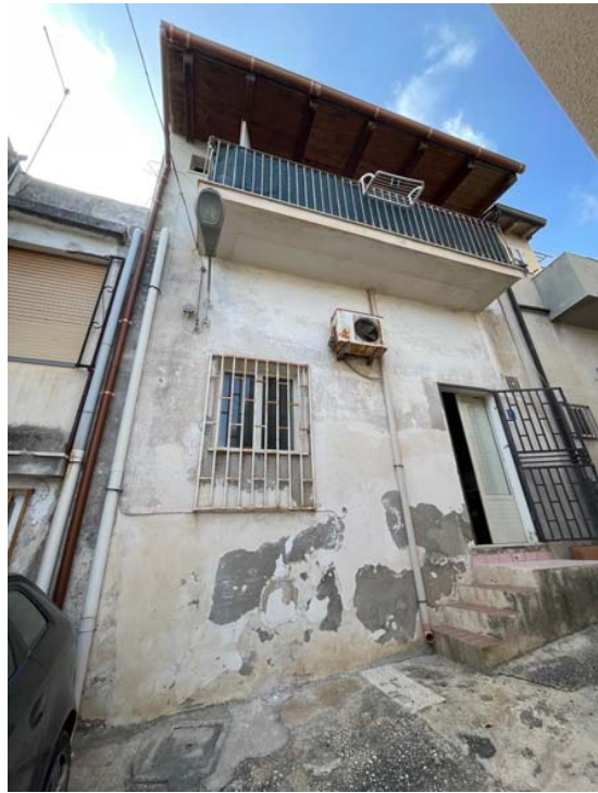
Vista del vicolo esterno al fabbricato
