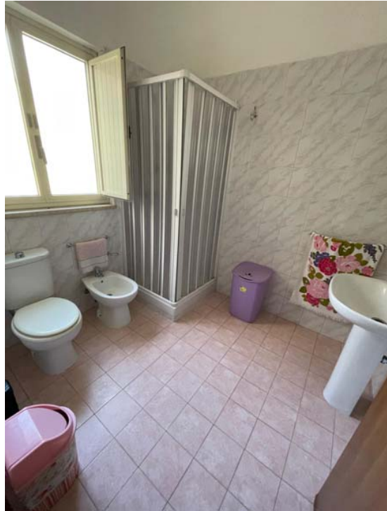
Piano terra - vista interna dell'abuso
