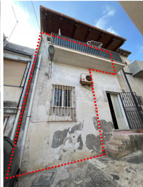
Vista interna fabbricato – individuazione degli abusi
