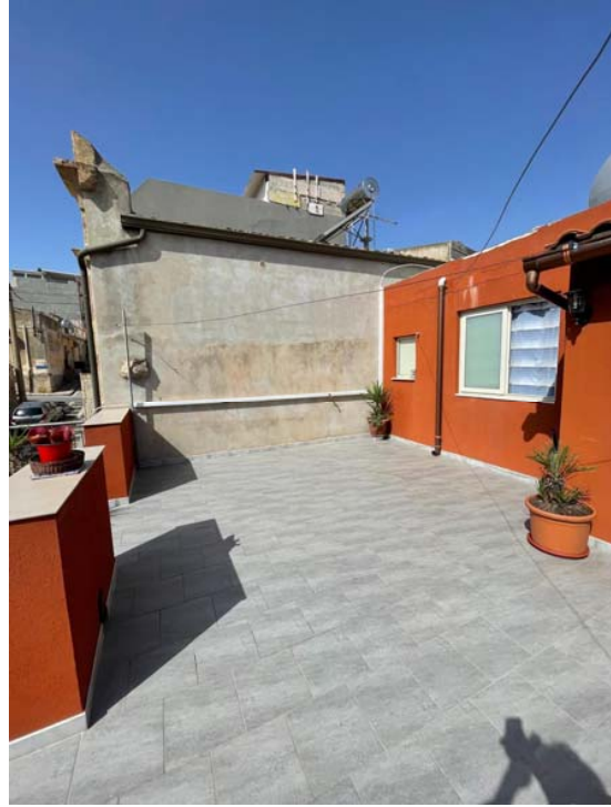
Primo piano – vista esterna dell'abuso
