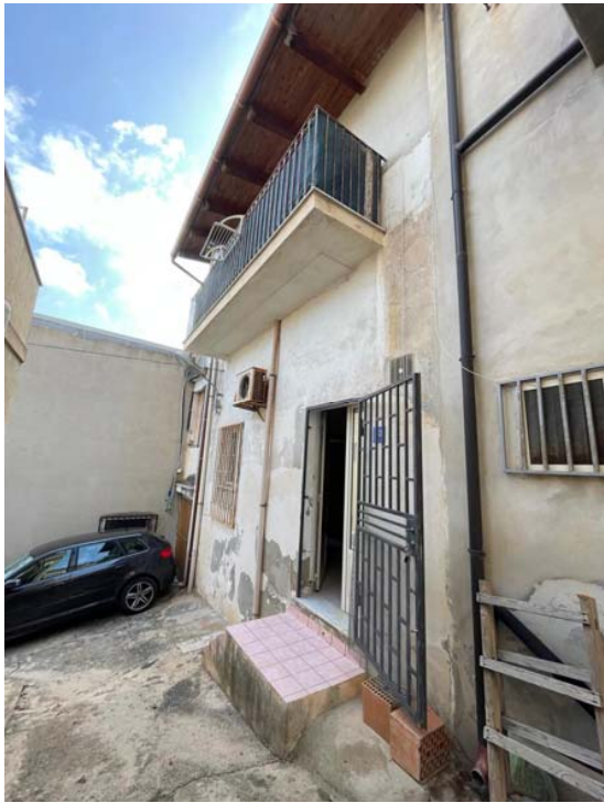
Vista del vicolo esterno al fabbricato
