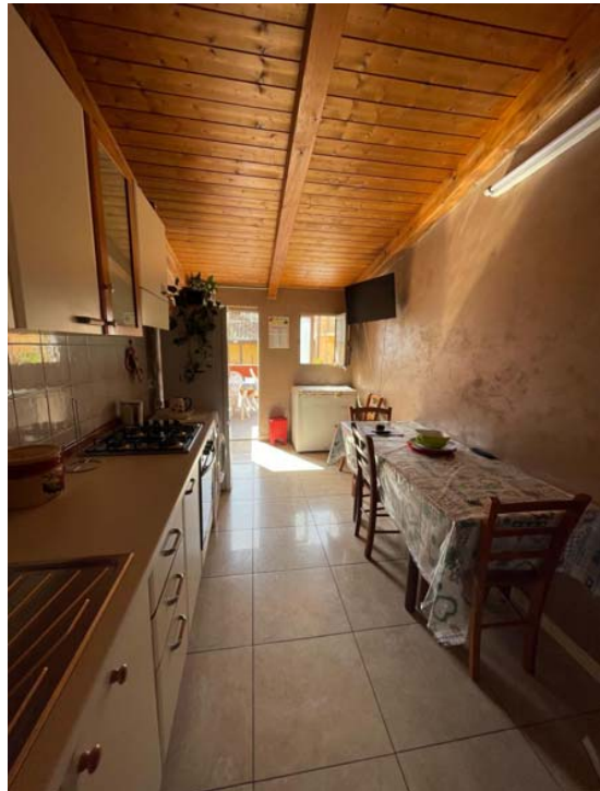
Piano primo - vista interna dell'abuso
