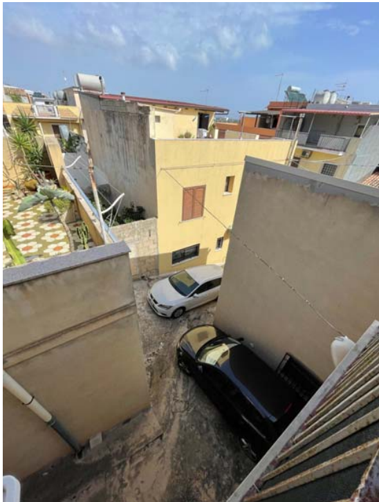
Affaccio dal balcone del primo piano sul vicolo
