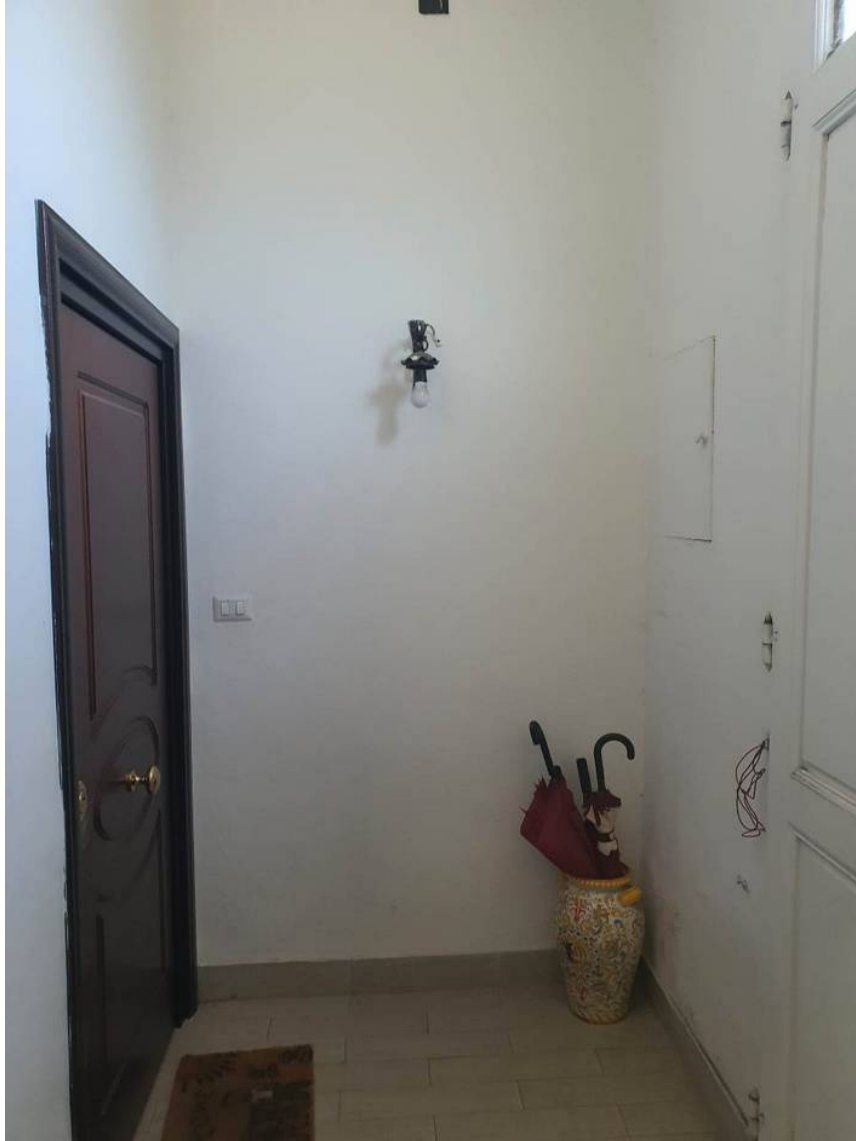
Foto 02 – Ingresso a comune.
