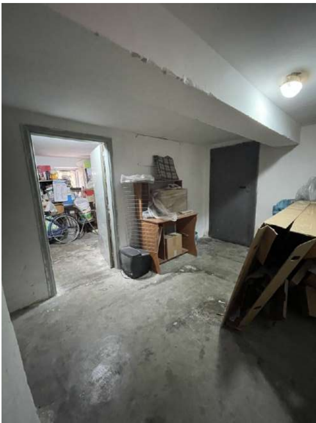
Figura 13. LOTTO UNICO: Immobile pignorato al F. 30, P.IIa 260, Sub. 16 ubicato in San Severo alla Via Giulio Cesare n. A/18 (corridoio comune di accesso alle cantine poste al piano seminterrato).
