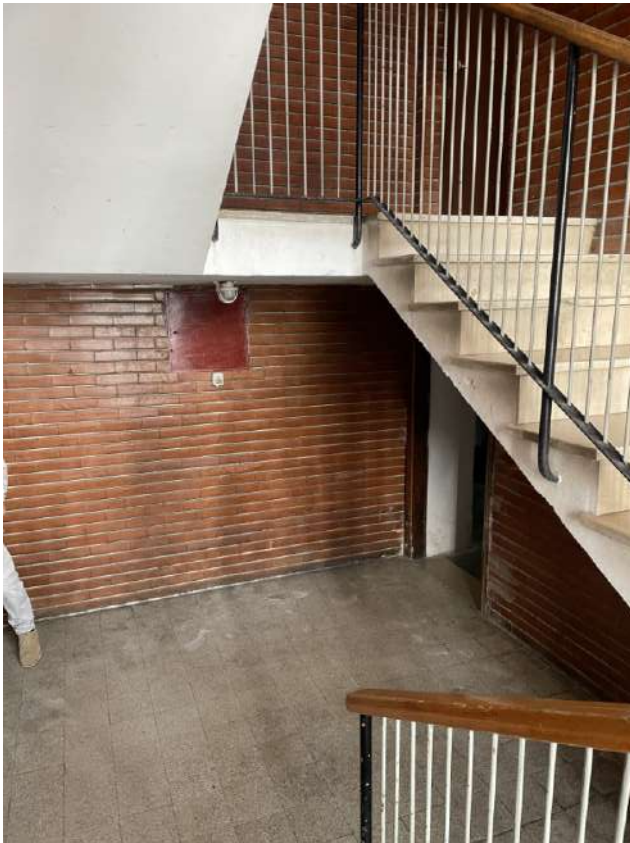
Figura 12. LOTTO UNICO: Immobile pignorato al F. 30, P.IIa 260, Sub. 16 ubicato in San Severo alla Via Giulio Cesare n. A/18 (androne di accesso alle cantine al piano seminterrato).
