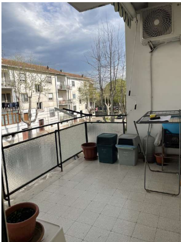
Figura 6. LOTTO UNICO: Immobile pignorato al F. 30, P.IIa 260, Sub. 16 ubicato in San Severo alla Via Giulio Cesare n. A/18 (balcone prospiciente la Via Giulio Cesare).
