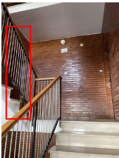
Figura 4. LOTTO UNICO: Fabbricato in cui si trova l'immobile pignorato al F. 30, P.IIa 260, Sub. 16 ubicato in San Severo alla Via Giulio Cesare n. A/18 (accesso dalla prima porta posta a sinistra del relativo pianerottolo).
