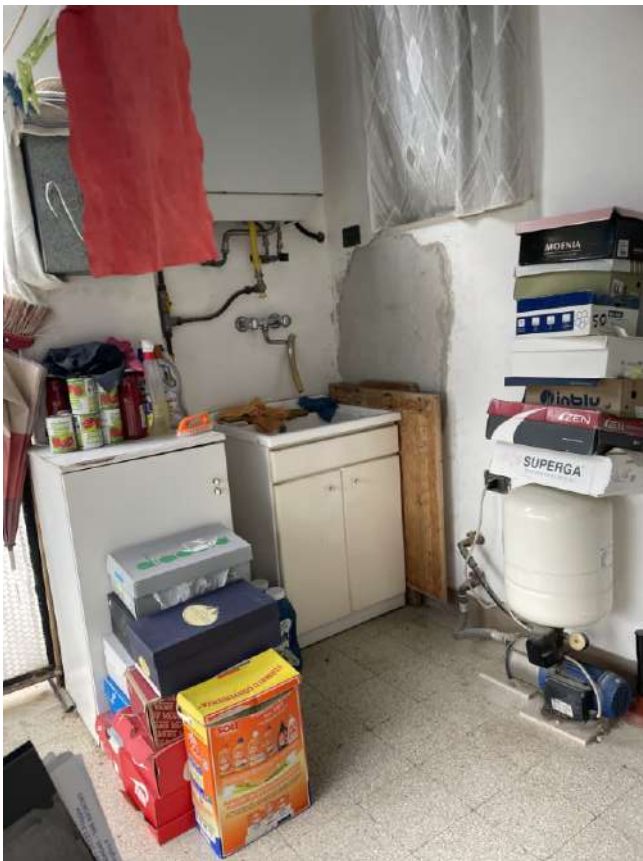
Figura 10. LOTTO UNICO: Immobile pignorato al F. 30, P.IIa 260, Sub. 16 ubicato in San Severo alla Via Giulio Cesare n. A/18 (balcone con accesso dal bagno).
