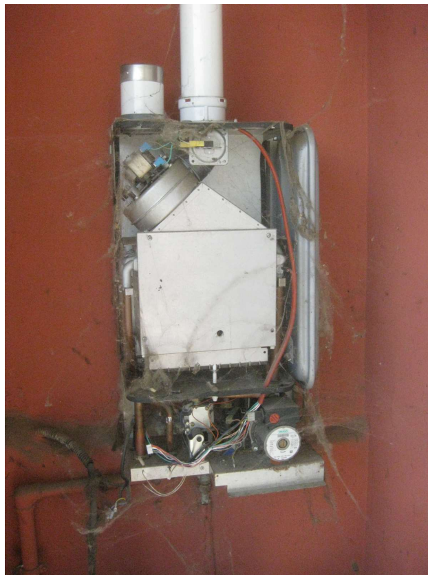
Foto 10 – Caldaia autonoma
