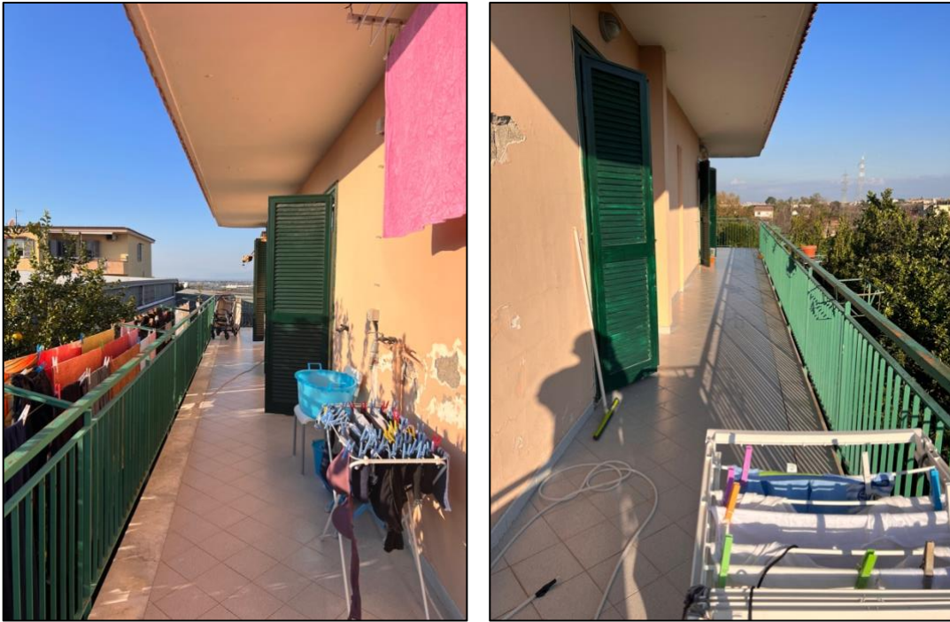
Foto 19/20 – Balcone lato sud/ovest
