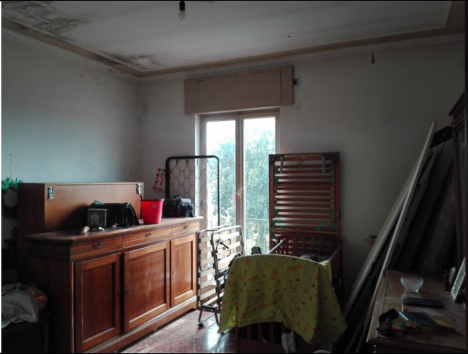
Foto n.20 – Foto interna Abitazione - piano primo - bene n.2
