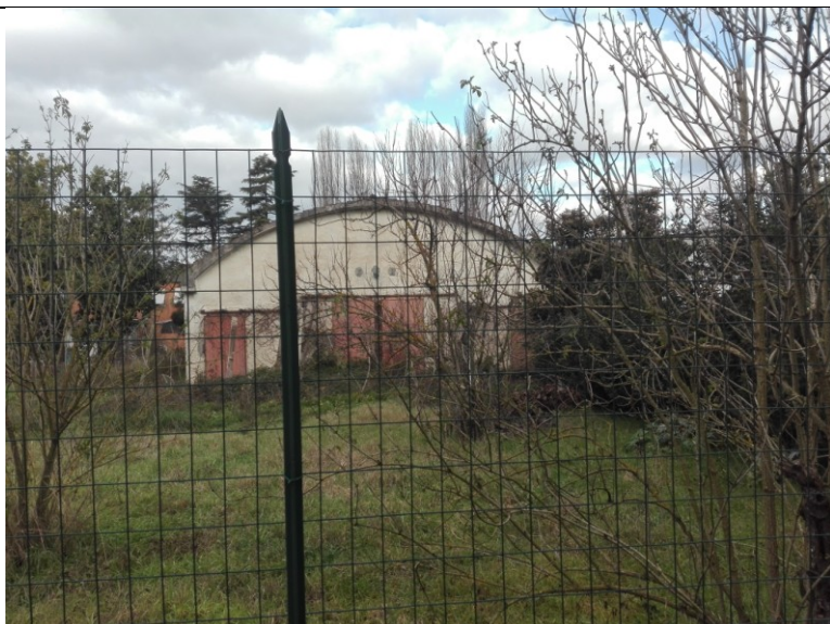
Foto n.4 – Prospetto retro degli immobili - bene n.1
