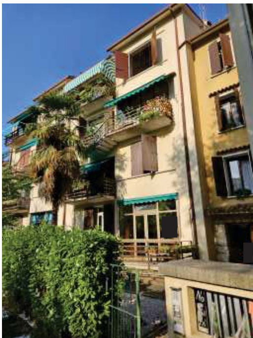
FOTO 1 : vista esterna lato sud
