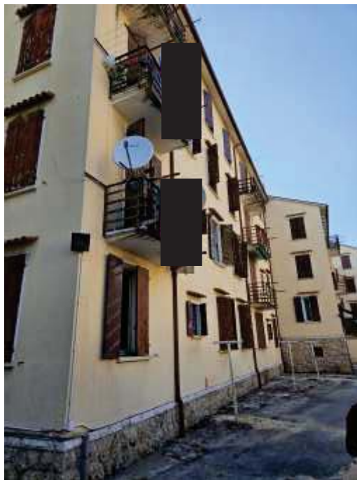
FOTO 2 : vista esterna lato nord
