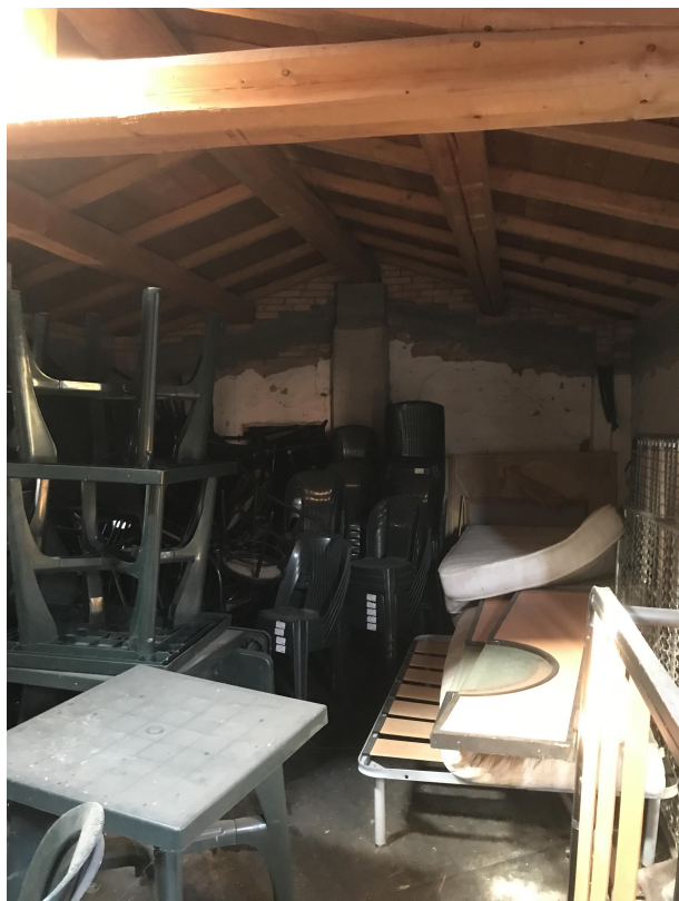
Deposito piano primo
