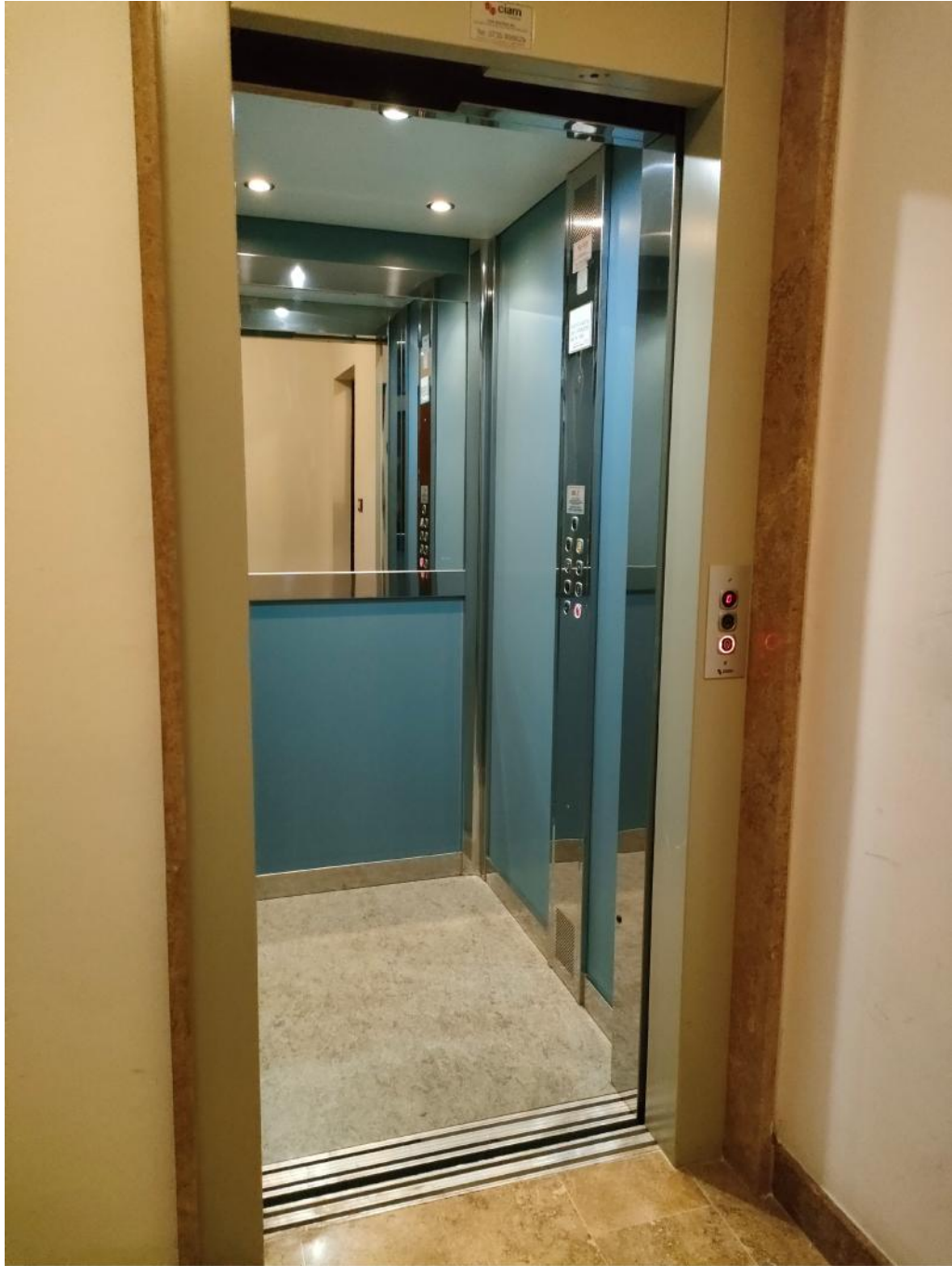
VANO ASCENSORE CONDOMINIALE
