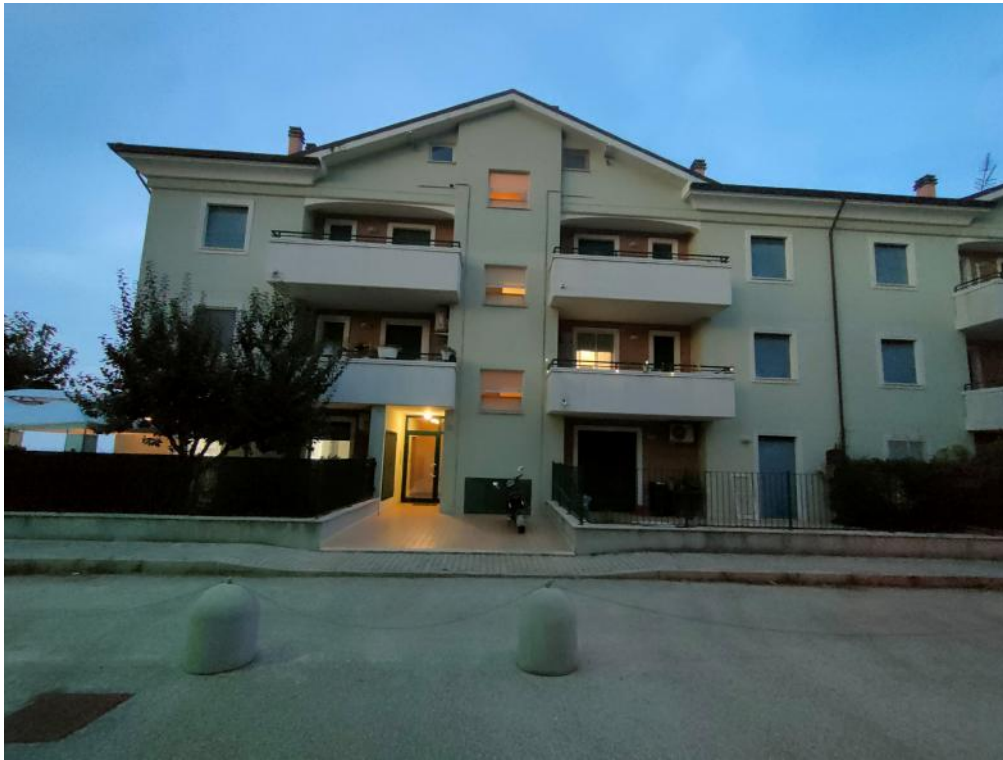
INGRESSO CONDOMINIO PALAZZINA A
