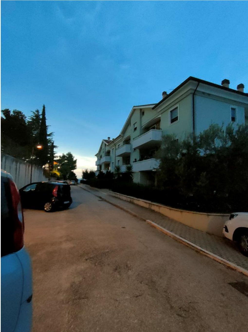
ACCESSO ALLA PALAZZINA DA VIA PAOLO MICHETTI
