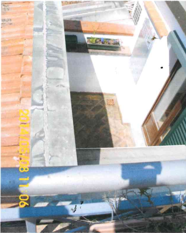
Foto 34:terrazzino al secondo piano dal lastrico solare
