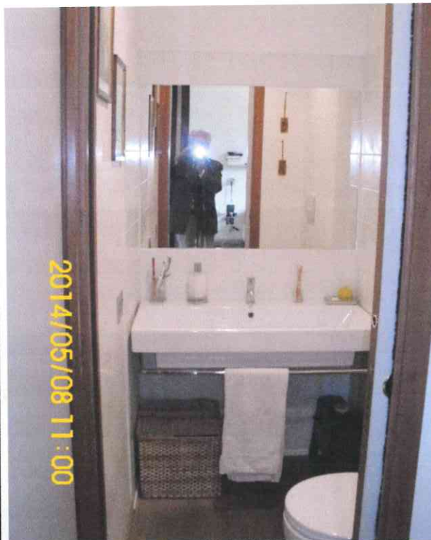
Foto 11:Bagno al piano primo
