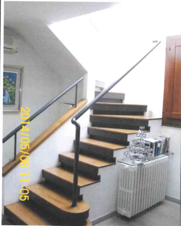
Foto 33:scala accesso al lastrico solare
