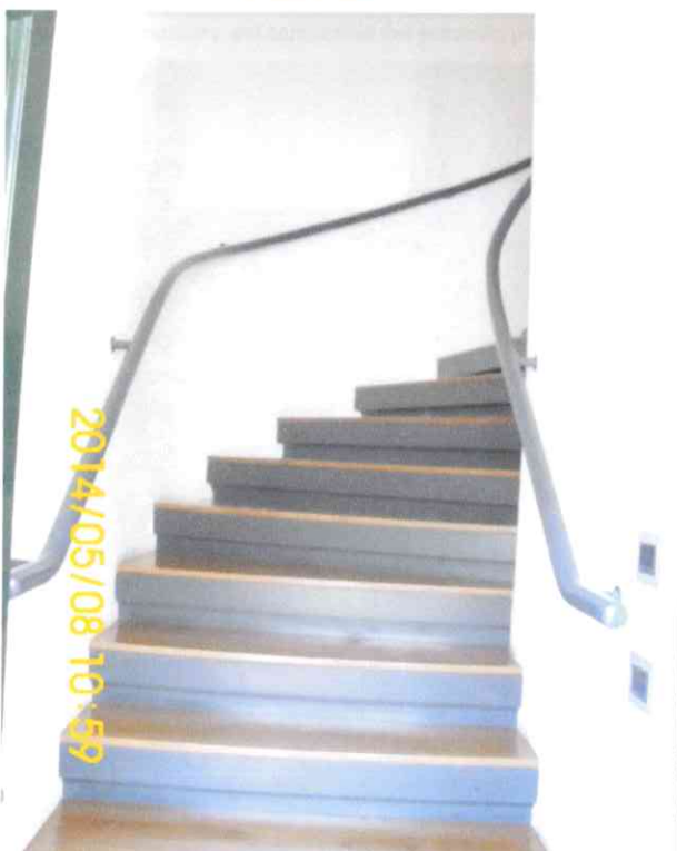
Foto 4:Scale accesso al piano primo
