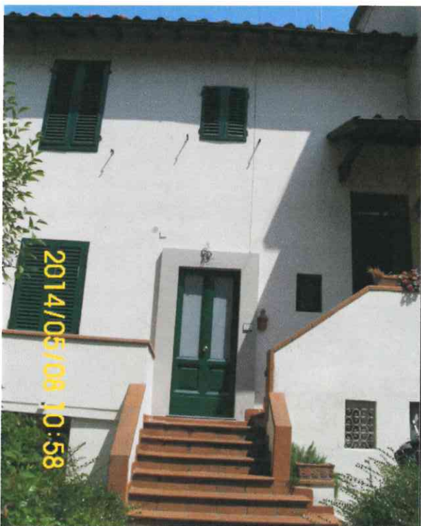
Foto 3:Rampa d'accesso all'ingresso
