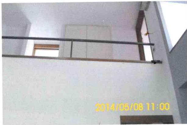
Foto 9:Ballatoio piano secondo
